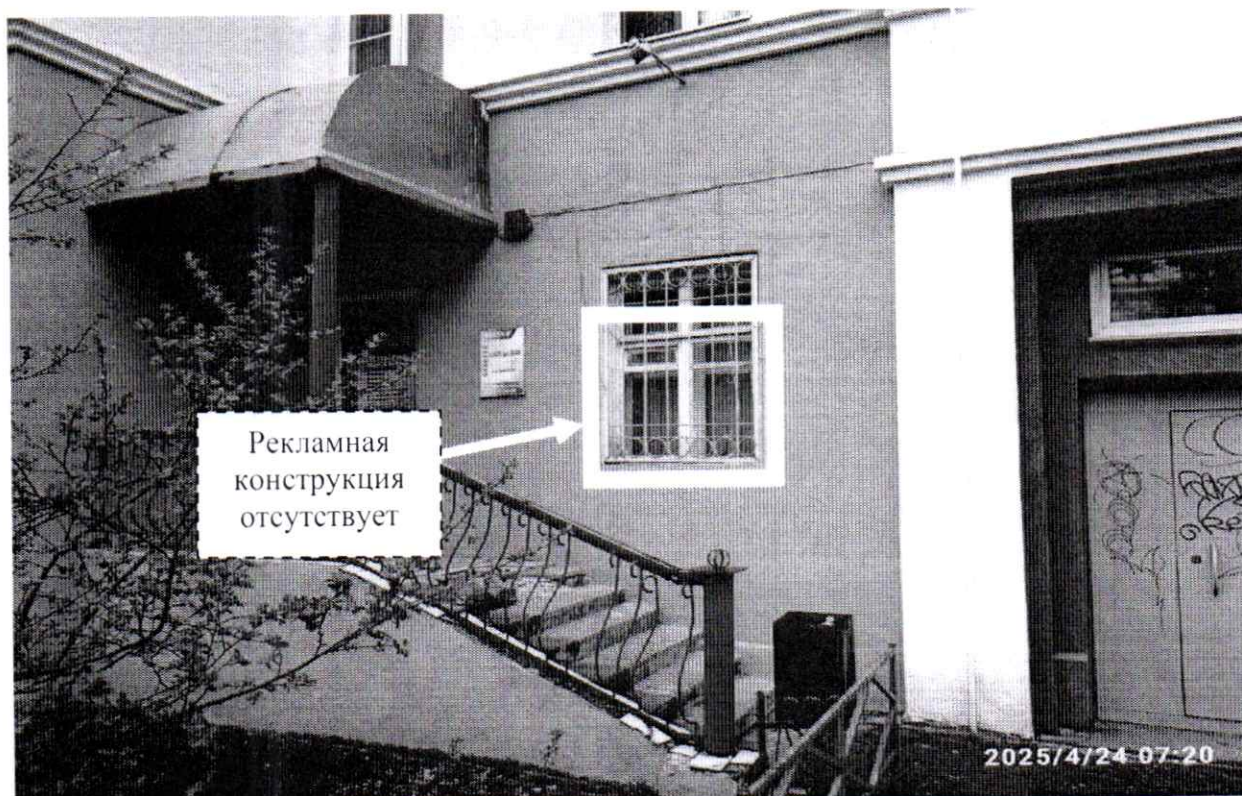
Фото № 2: ул. Октябрьская, д. 26 – после проведения работ по демонтажу.
