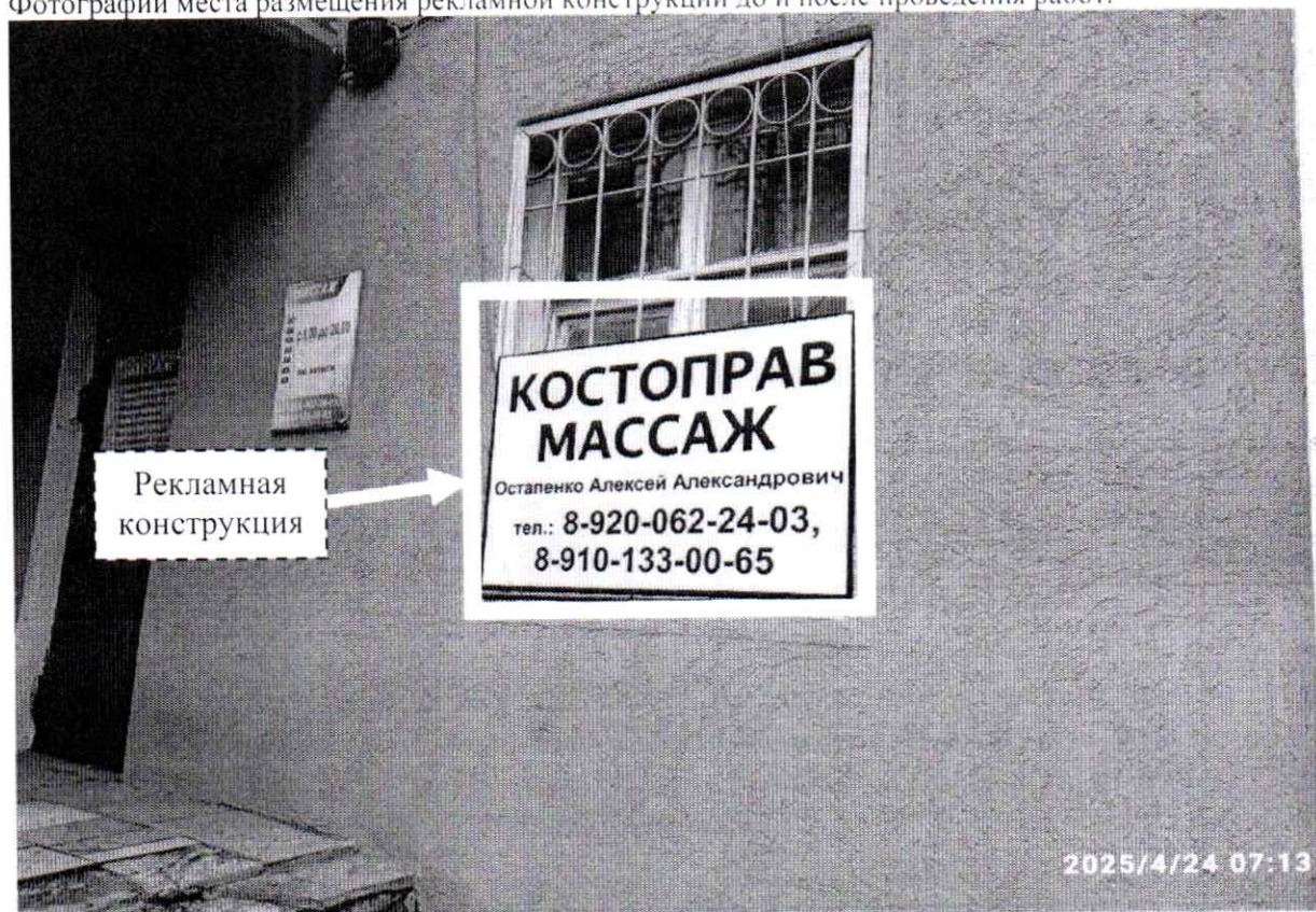
Фото № 1: ул. Октябрьская, д. 26 – до проведения работ по демонтажу.
