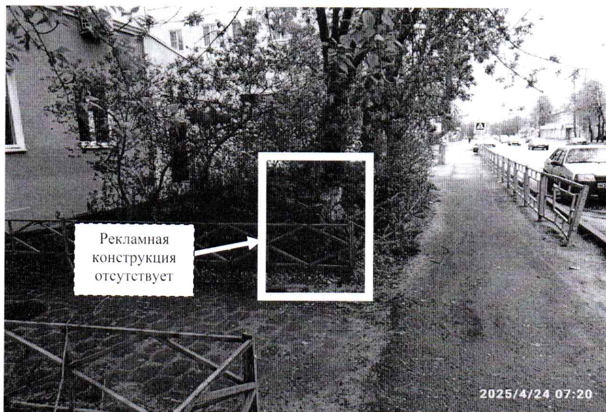
Фото № 2: ул. Октябрьская, д. 26 – после проведения работ по демонтажу.
