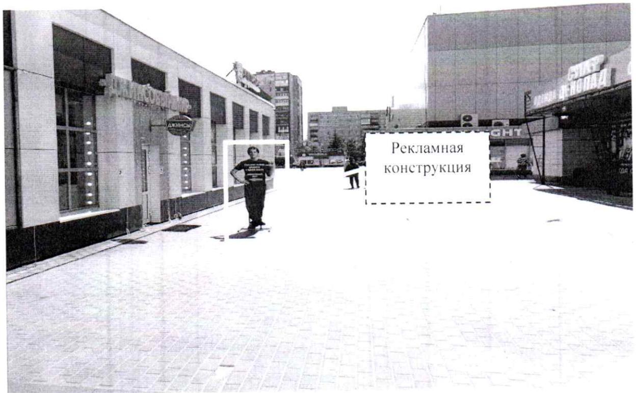
Фото № 1: Панорамный вид размещения рекламной конструкции
