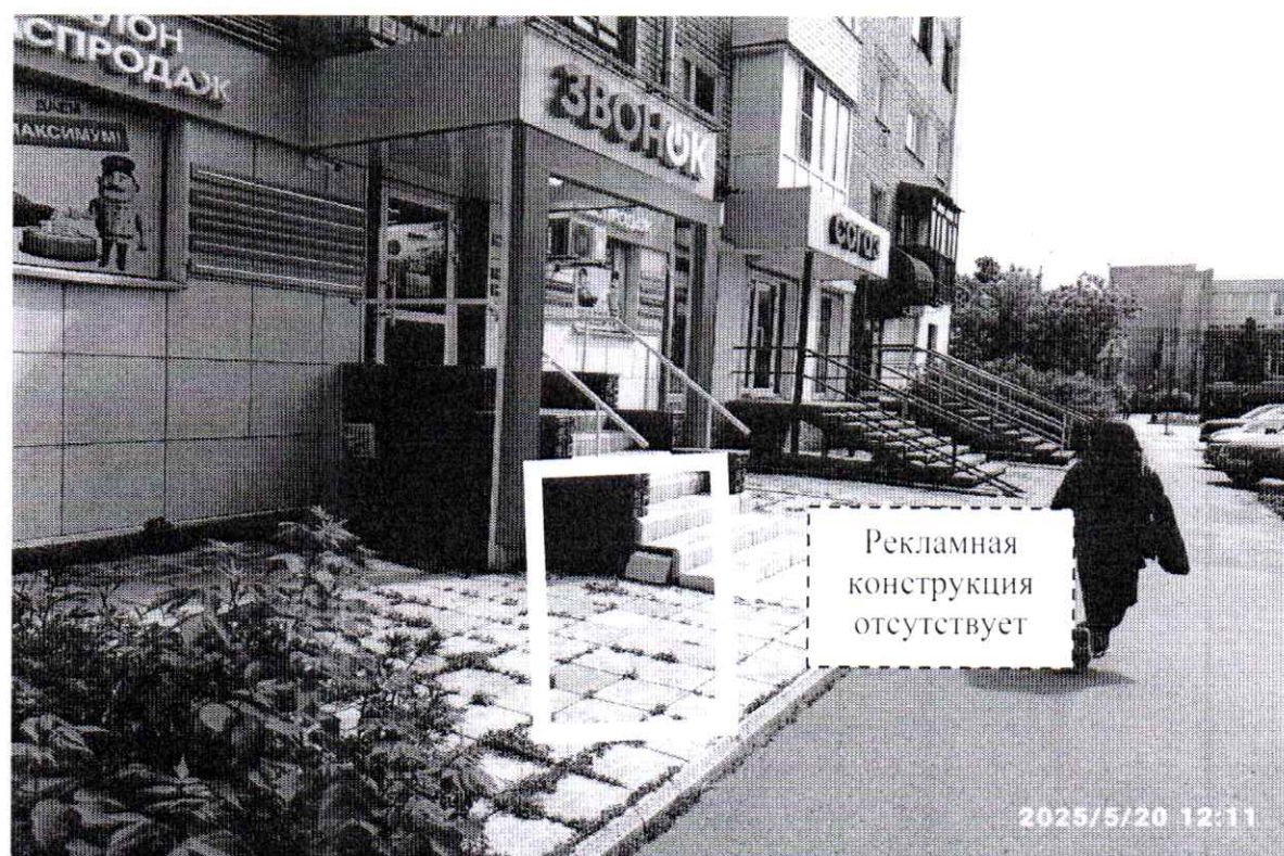
Фото № 2: бул. Мира, д. 33 – после проведения работ по демонтажу.
