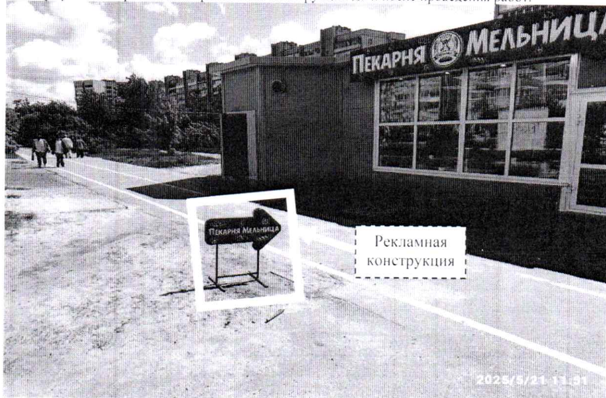
Фото № 1: пр. Циолковского, д. 75/1 – до проведения работ по демонтажу.
