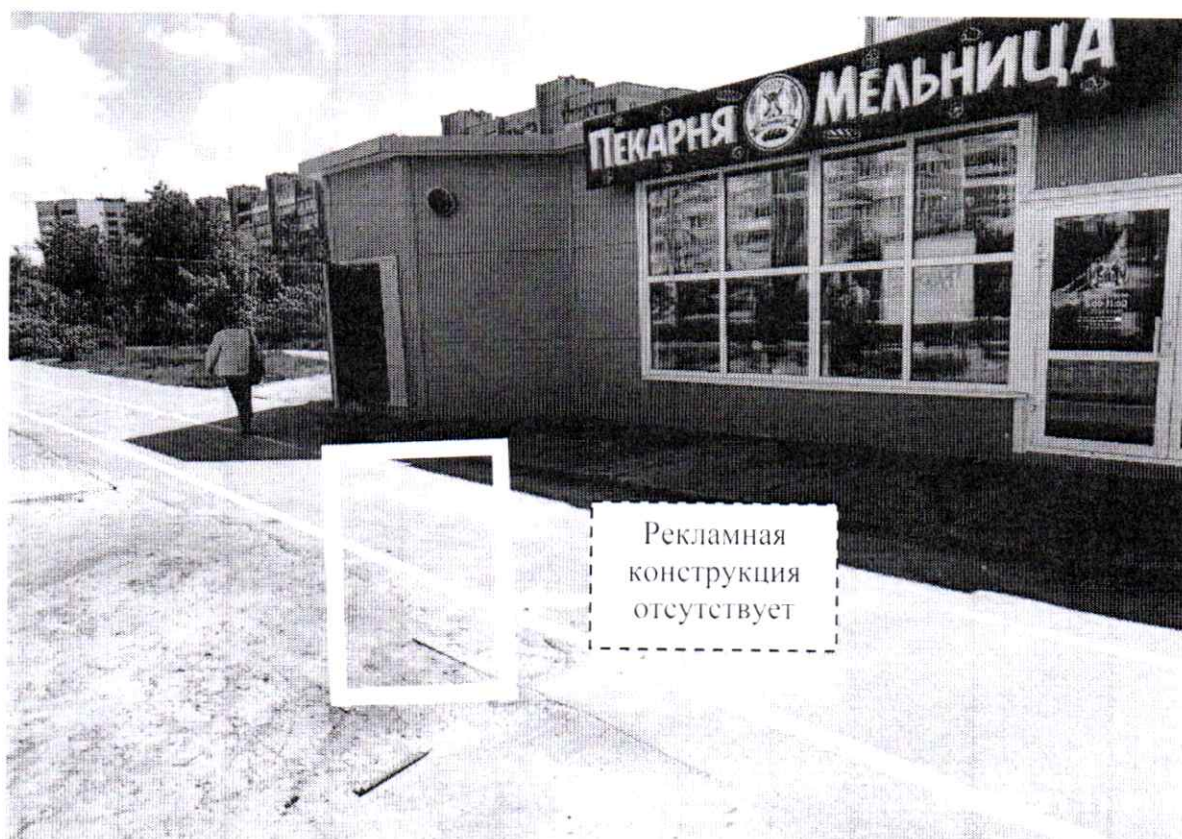
Фото № 2: пр. Циолковского, д. 75/1 – после проведения работ по демонтажу.
