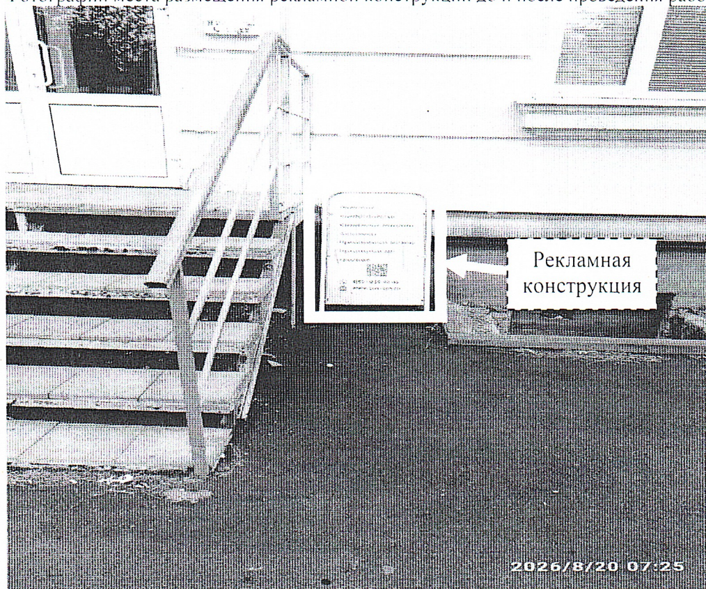
Фото № 1: пр. Ленина, д. 59 – до проведения работ по демонтажу.
