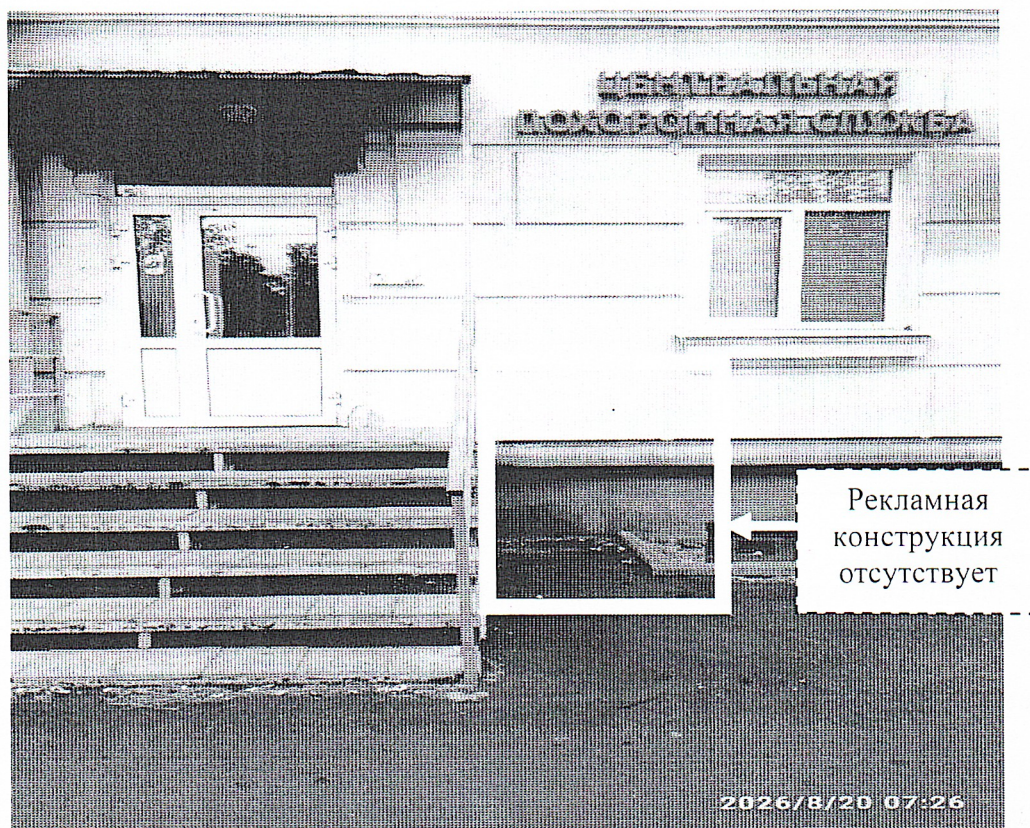
Фото № 2: пр. Ленина, д. 59 – после проведения работ по демонтажу.
