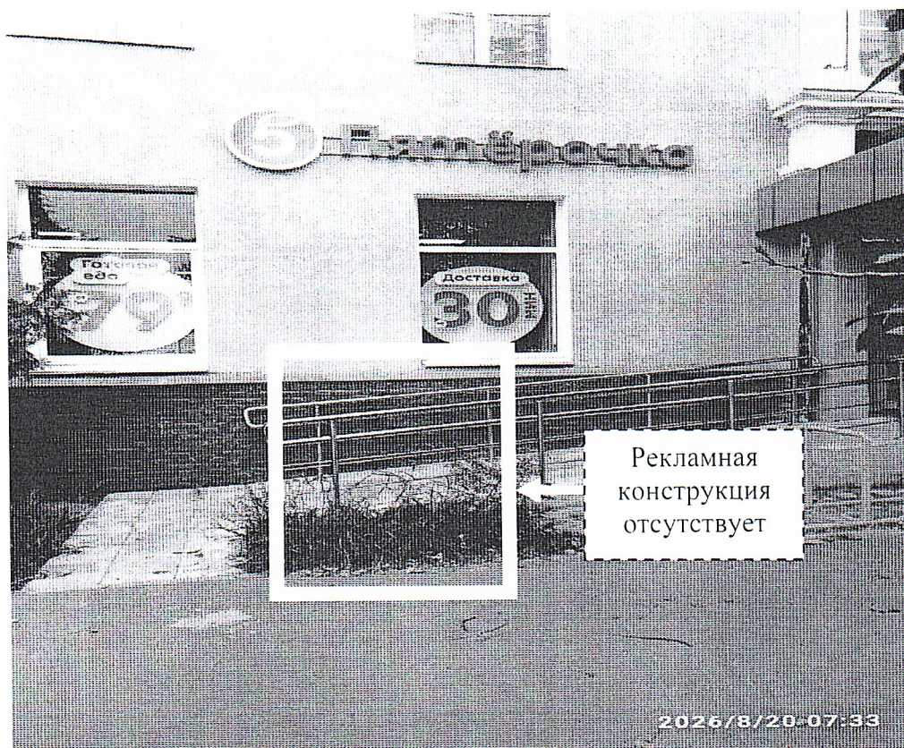
Фото № 2: ул. Пирогова, д. 3 – после проведения работ по демонтажу.
