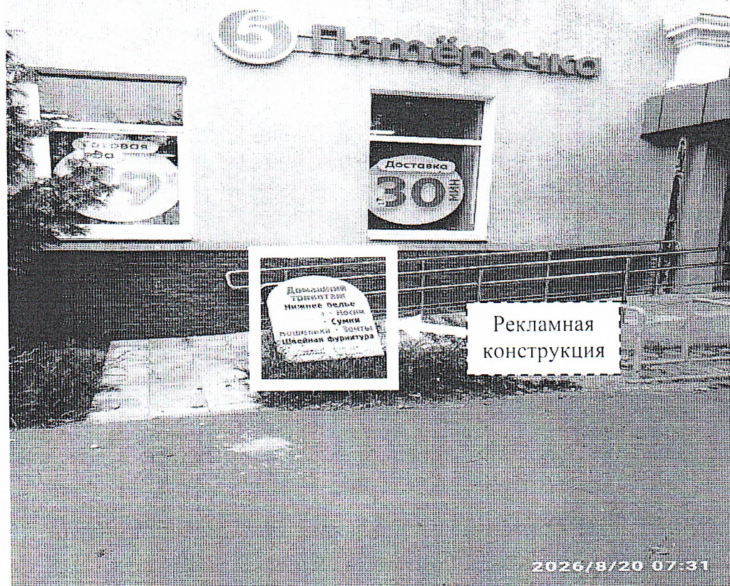
Фото № 1: ул. Пирогова, д. 3 – до проведения работ по демонтажу.
