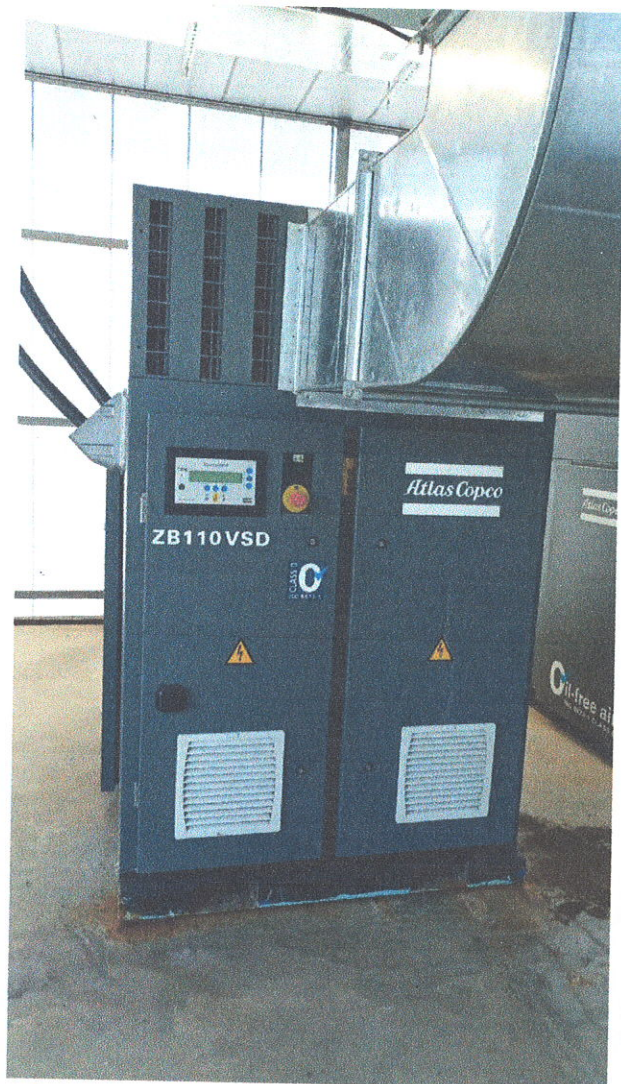
Агрегат воздуходувный с обвязкой №5
