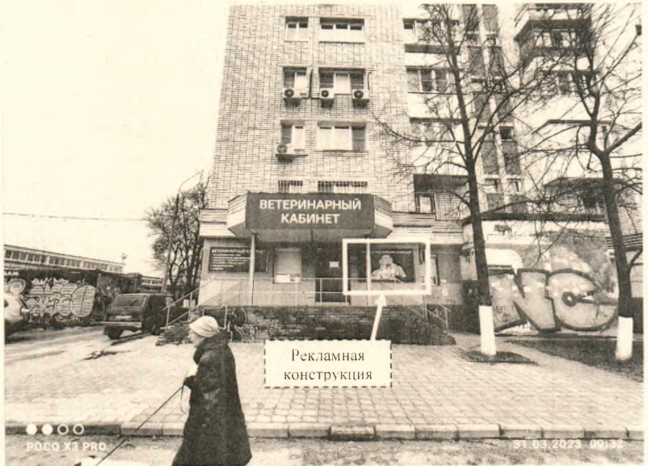
Фото № 1: Панорамный вид размещения рекламной конструкции
