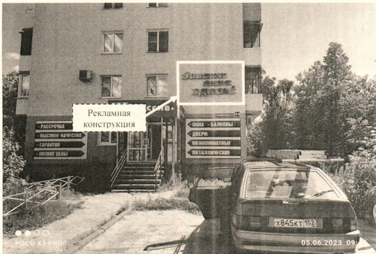
Фото № 1: Панорамный вид размещения рекламной конструкции
