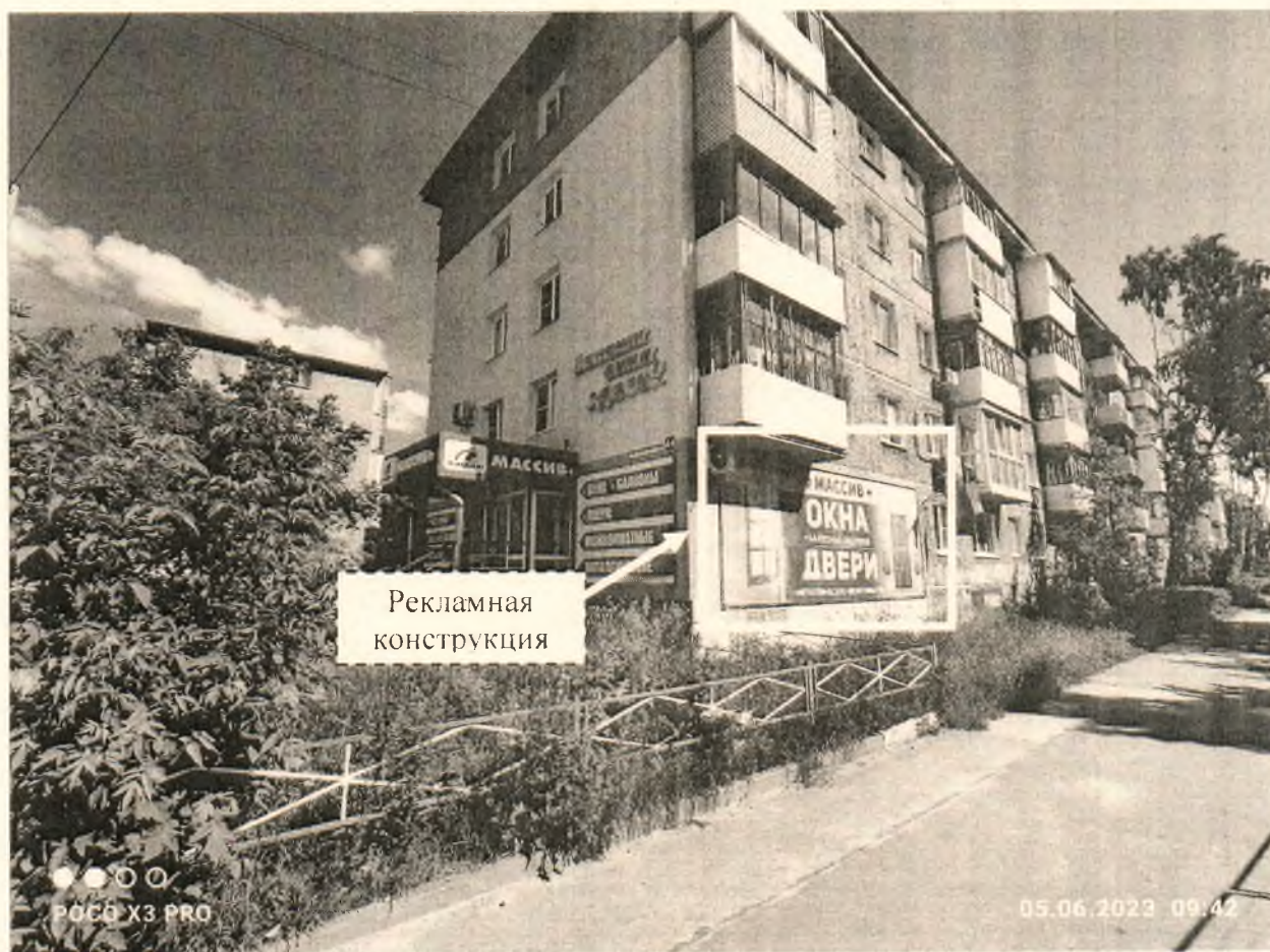
Фото № 1: Панорамный вид размещения рекламной конструкции
