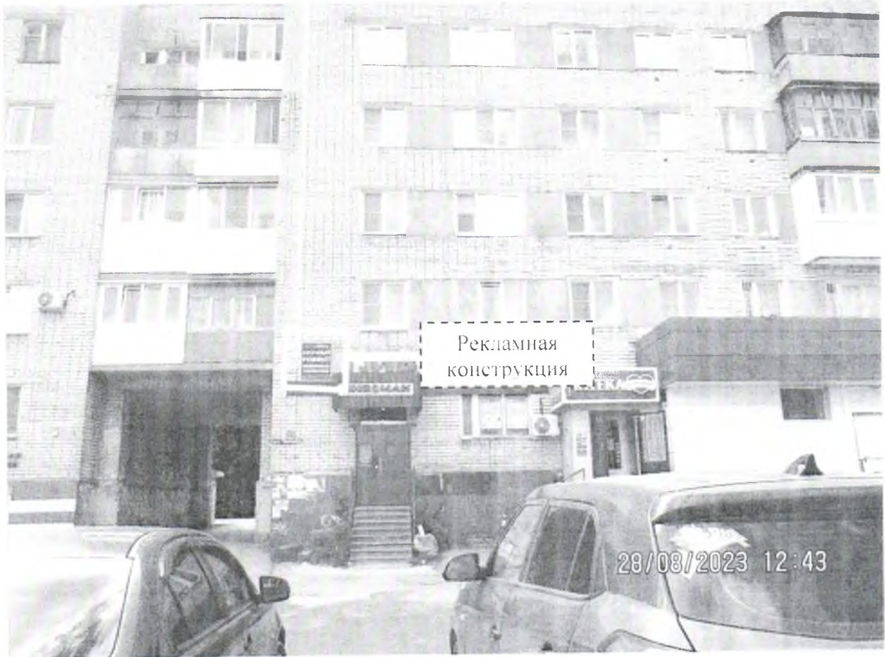
Фото № 1: Панорамный вид размещения рекламной конструкции
