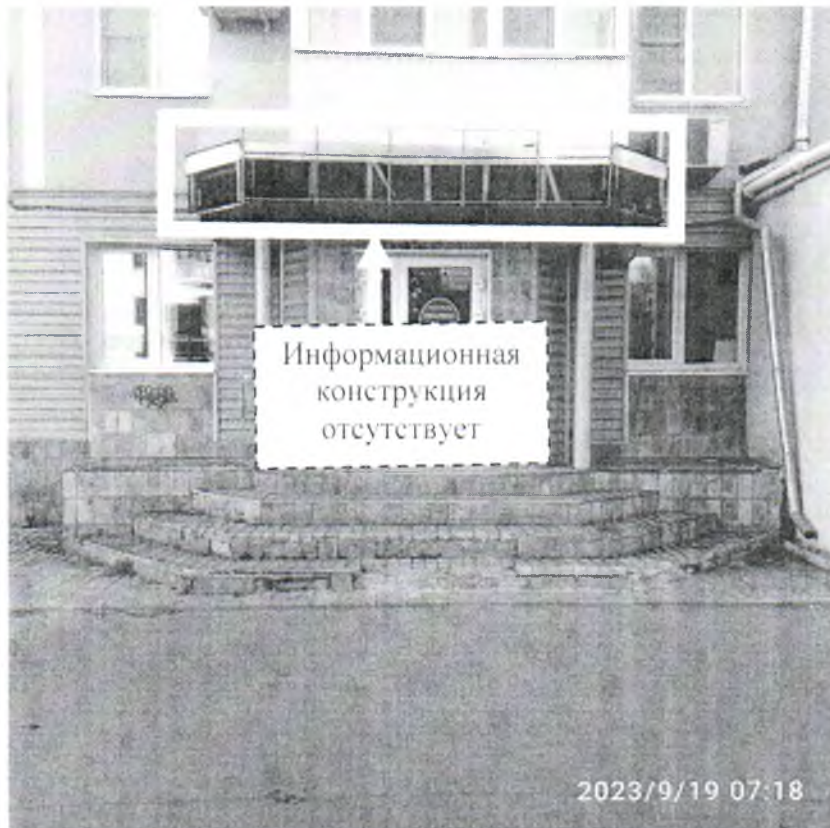
Фото №2: пр. Циолковского д.1 – после проведения работ по демонтажу.
