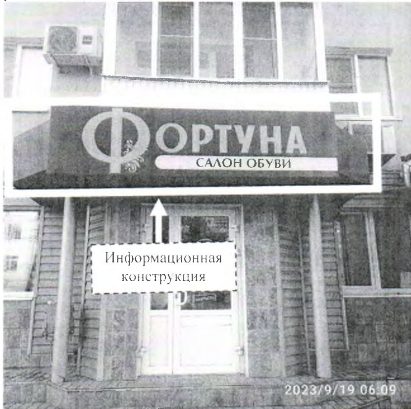
Фото №1: пр. Циолковского д.1 – до проведения работ по демонтажу.
