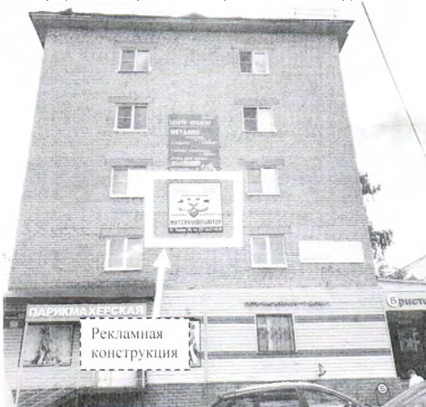
Фото №1: пр. Ленина, д. 50 – до проведения работ по демонтажу.
