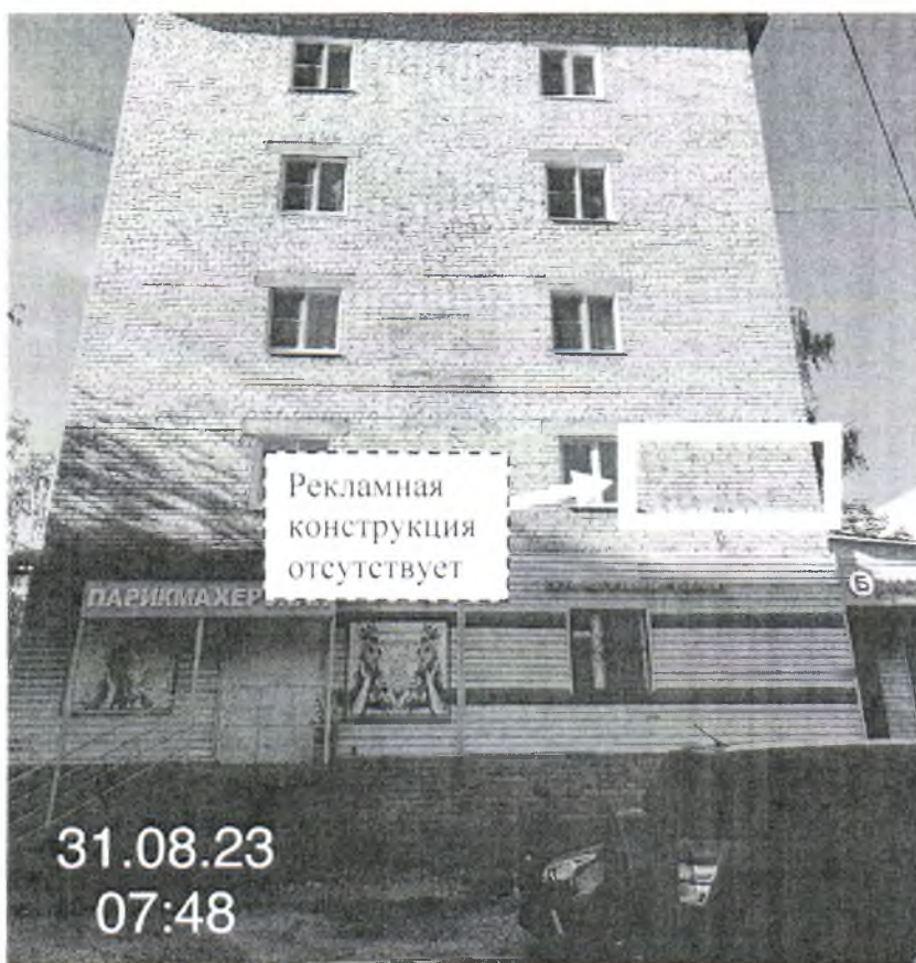
Фото №2: пр. Ленина, д. 50 – после проведения работ по демонтажу.
