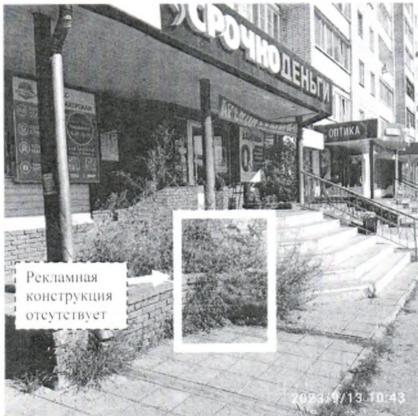
Фото №2: пр. Циолковского, в районе д. 74 – после проведения работ по демонтажу.
