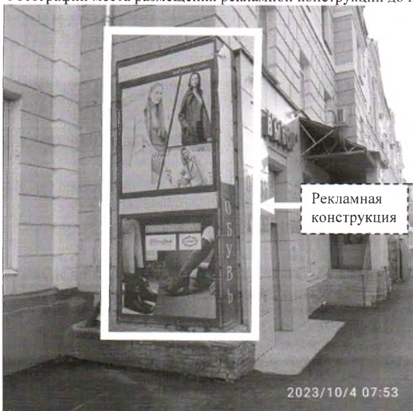
Фото №1: пр. Ленина, д. 49 – до проведения работ по демонтажу.
