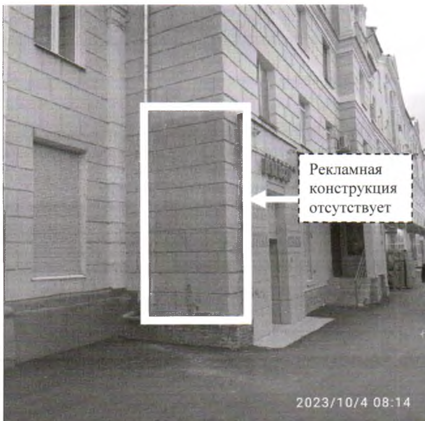
Фото №2: пр. Ленина, д. 49 – после проведения работ по демонтажу.
