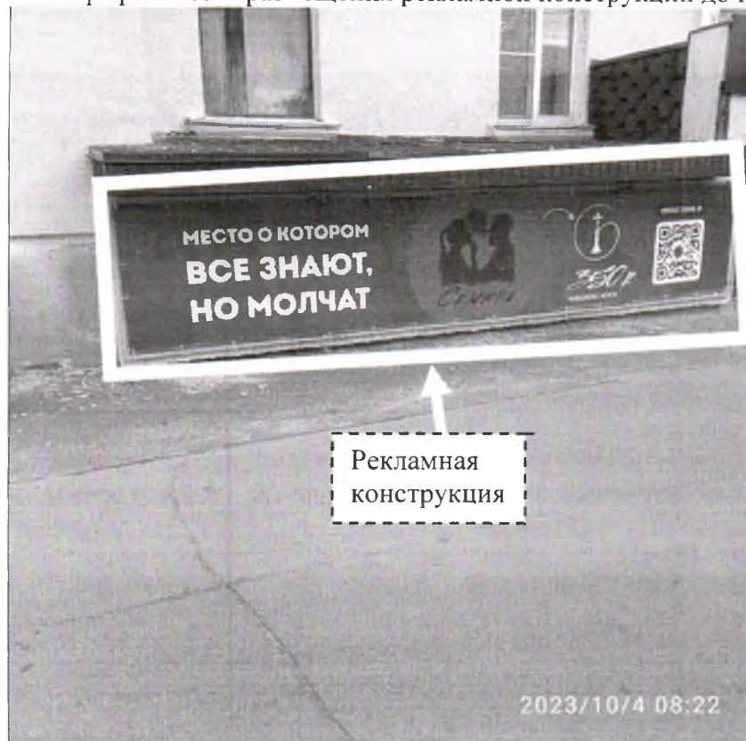
Фото №1: пр. Ленина, д. 85 – до проведения работ по демонтажу.
