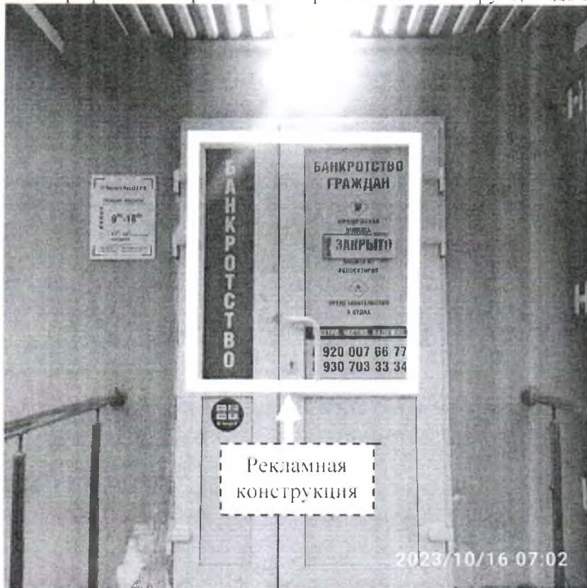
Фото №1: ул. Грибоедова, д. 23/10 – до проведения работ по демонтажу.
