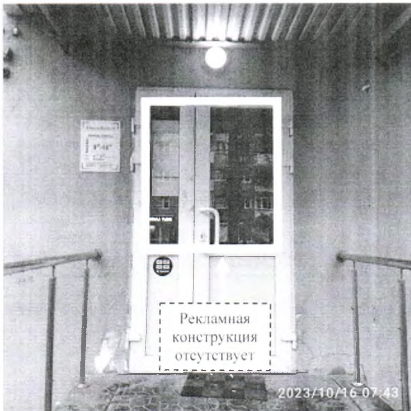
Фото №2: ул. Грибоедова, д. 23/10 – после проведения работ по демонтажу.
