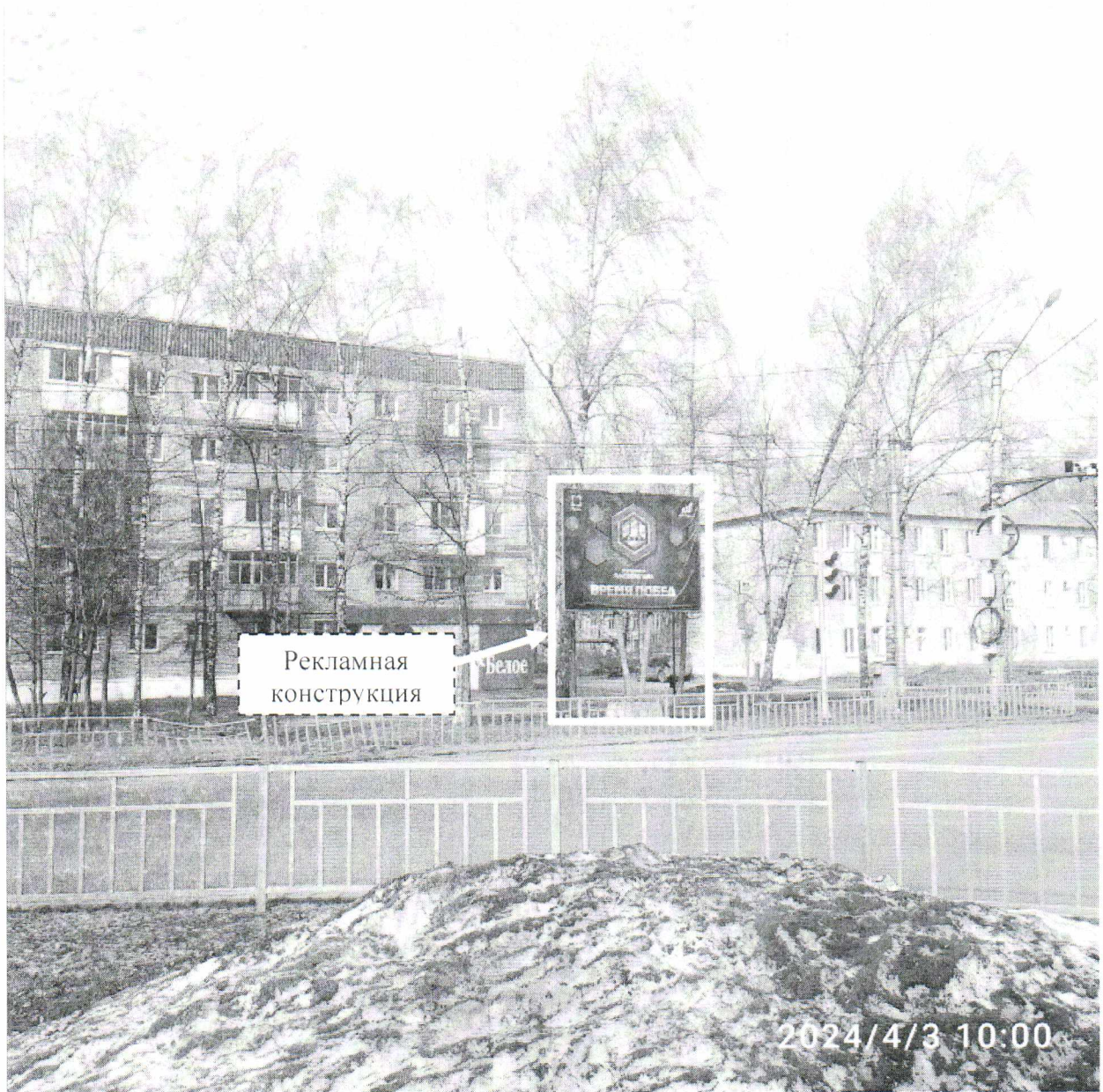
Фото № 1: Панорамный вид размещения рекламной конструкции
