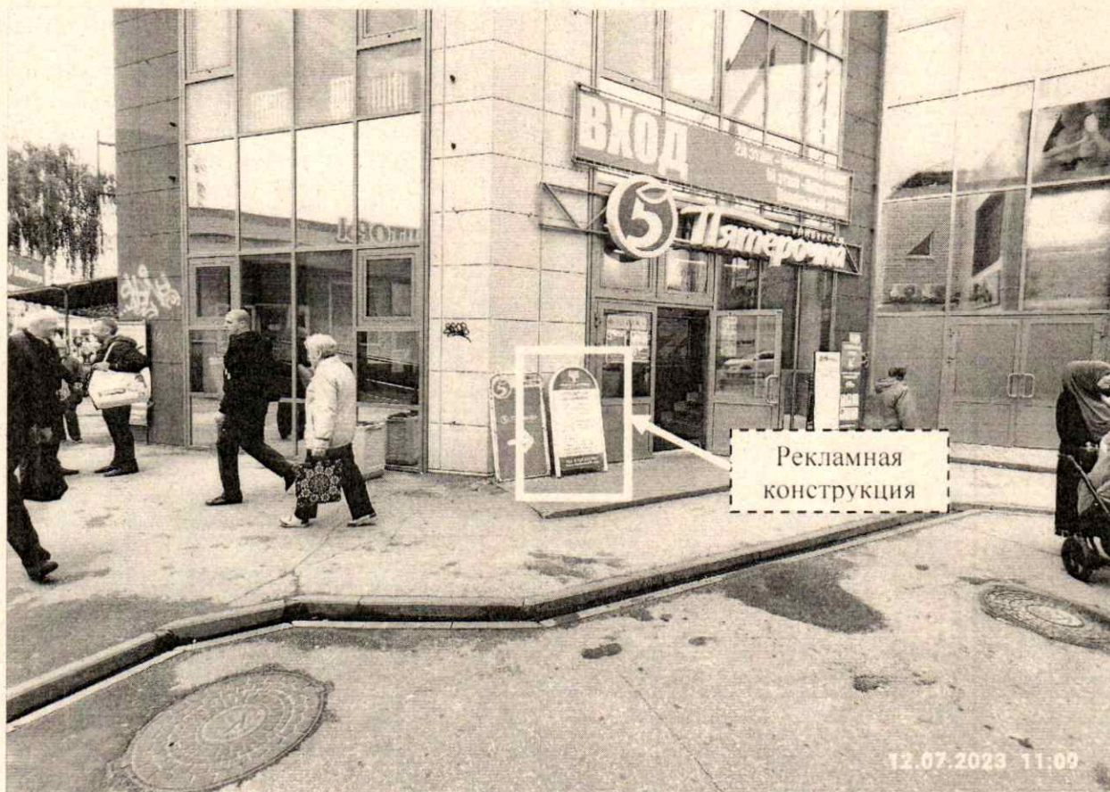
Фото № 1: Панорамный вид размещения рекламной конструкции
