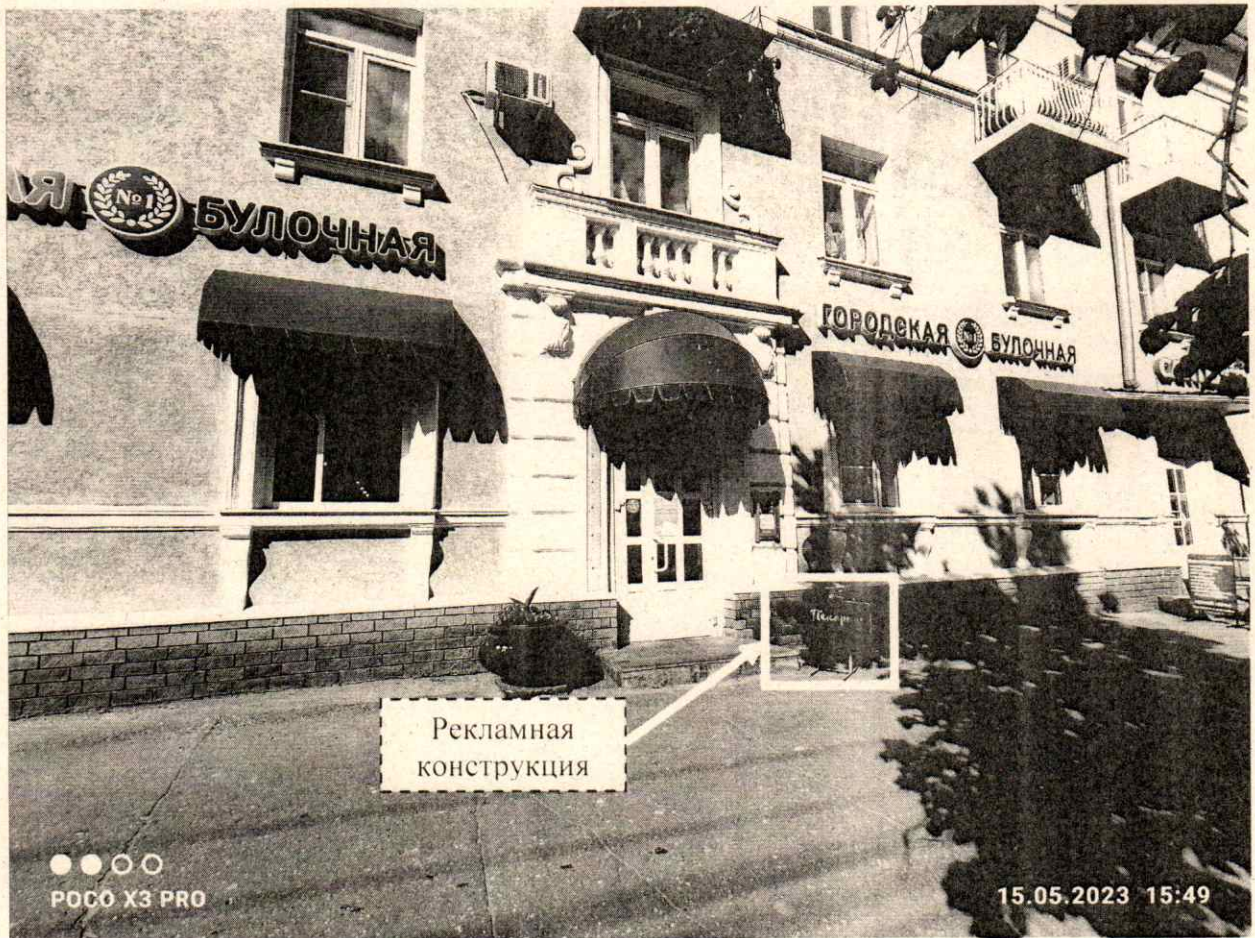
Фото № 1: Панорамный вид размещения рекламной конструкции
