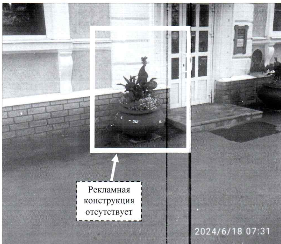
Фото № 2: пр-т Ленина. д. 41– после проведения работ по демонтажу.
