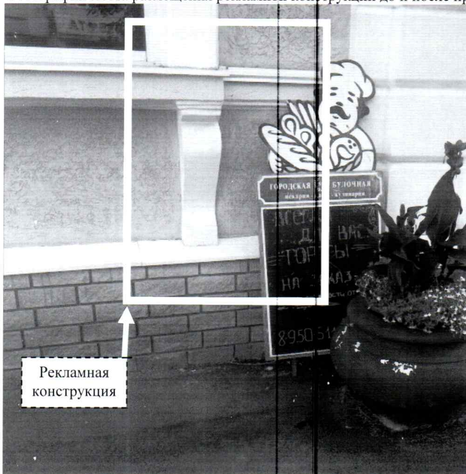
Фото № 1: пр-т Ленина. д. 41 – до проведения работ по демонтажу.
