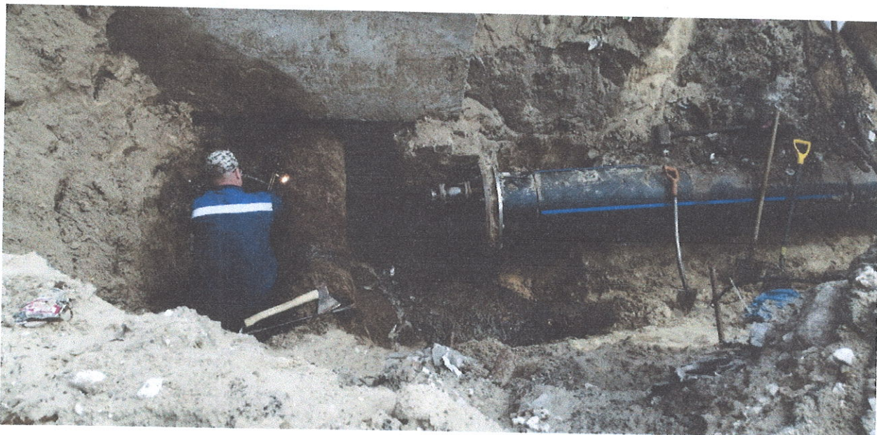
Прокладка трубопровода ул. Студенческая от пр. Ленина до пр. Дзержинского
