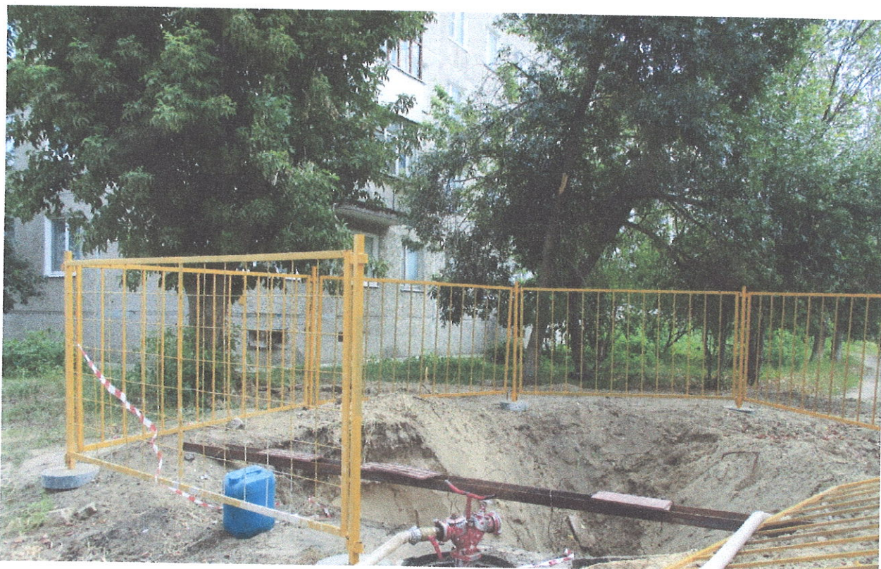
Прокладка сетей водоснабжения
