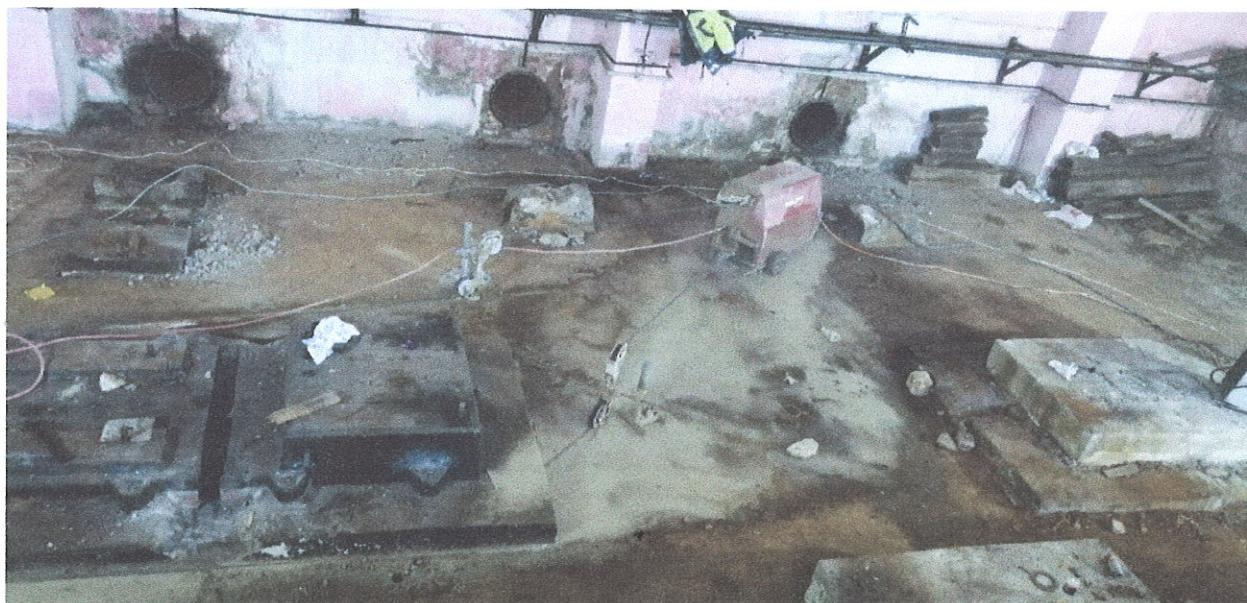
Проводятся работы по реконструкции производственного здания № 629, ул.Сухаренко, 10
