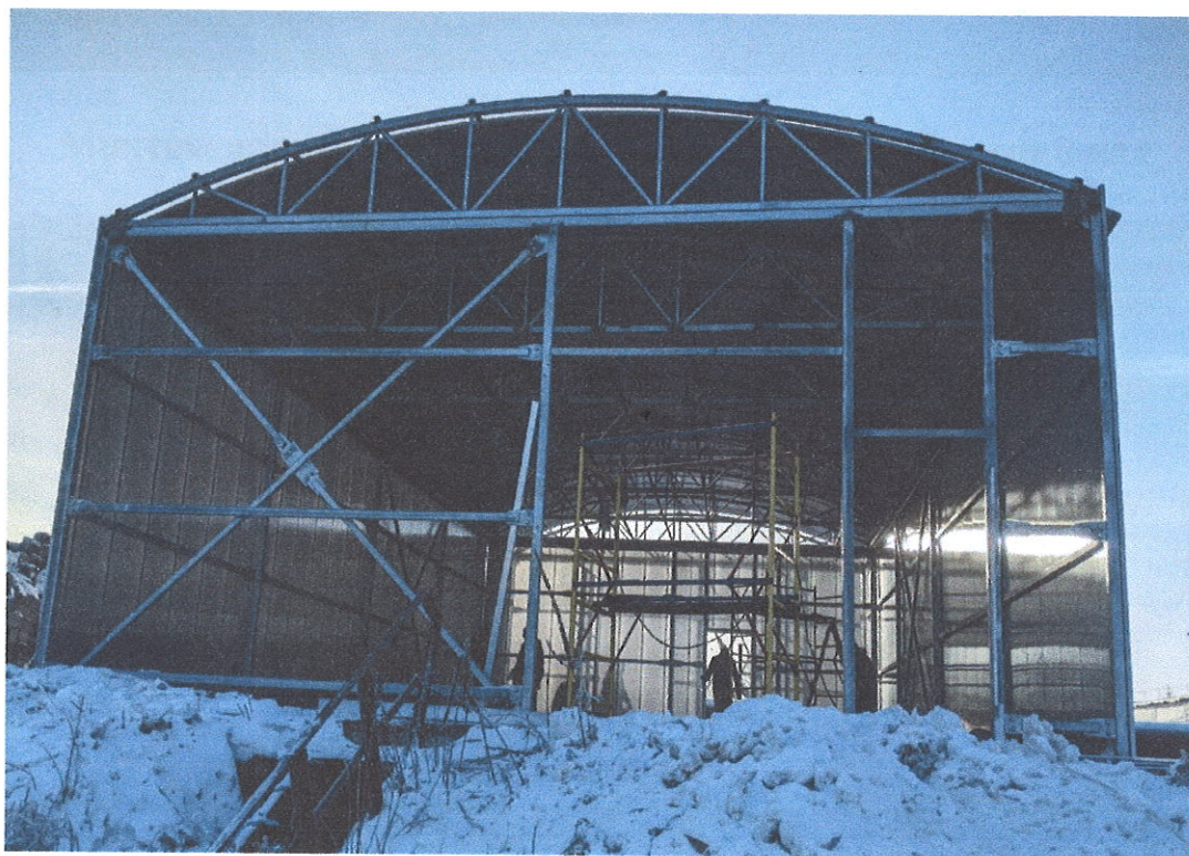
Монтаж павильона из легковозводимых конструкций над воздуходувными агрегатами
