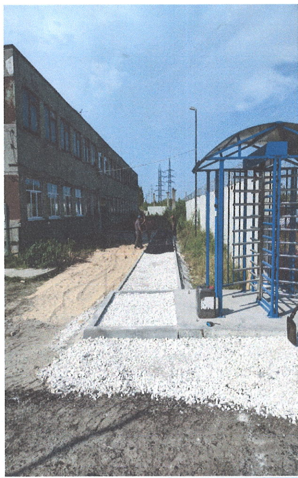
Монтаж полноростового роторного турникета
