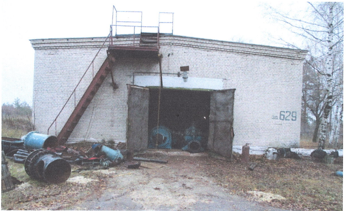
Начало реконструкции производственного здания № 629, ул.Сухаренко, 10
