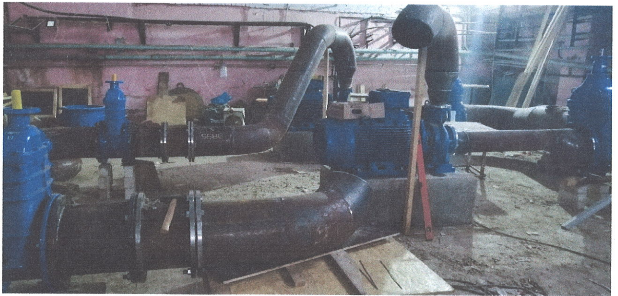
Прокладка внутриплощадочных сетей фильтрованной воды
