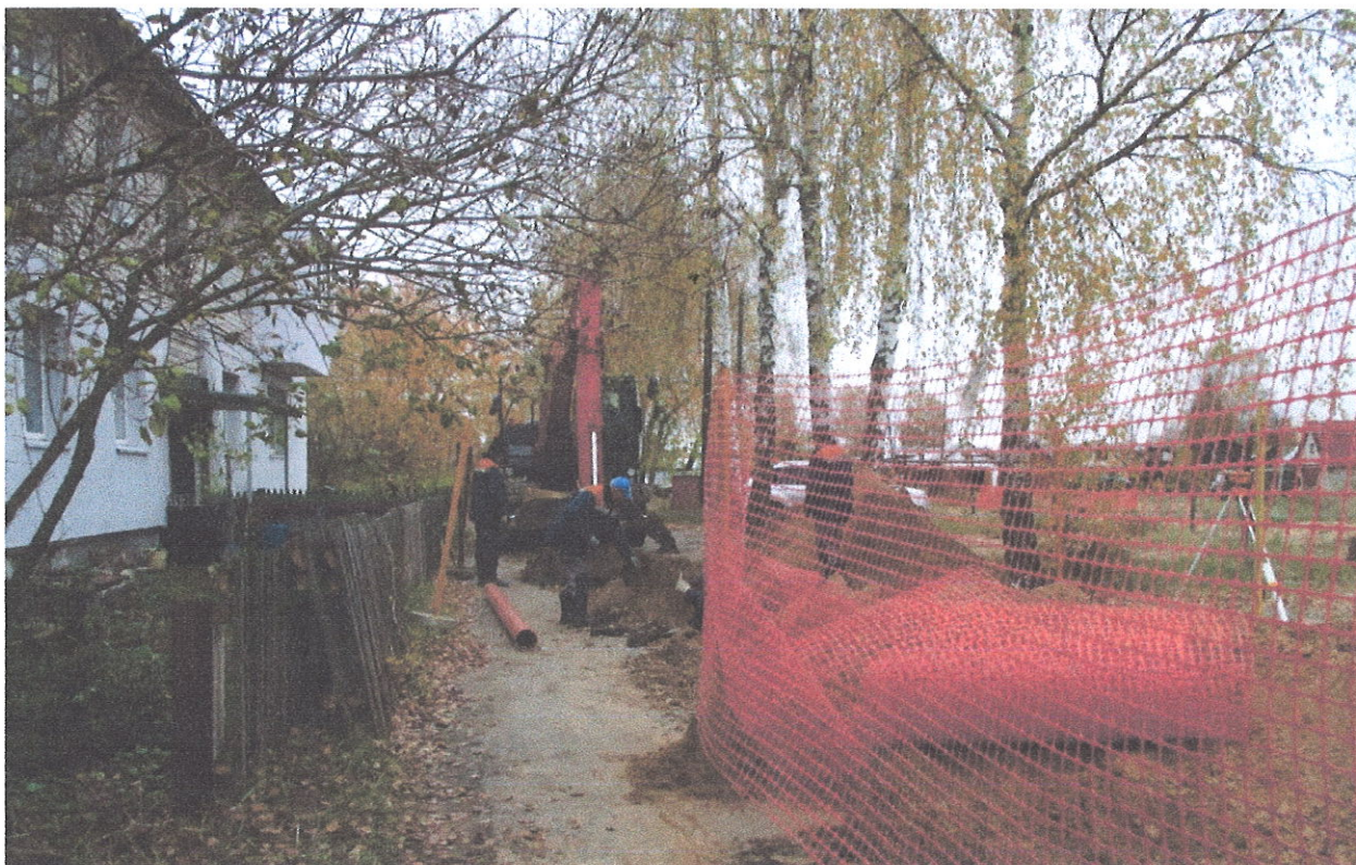
Прокладка сетей водоснабжения
