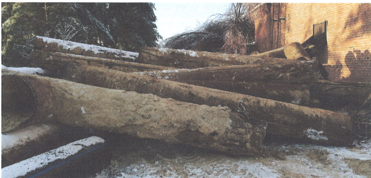
Демонтаж старого трубопровода
