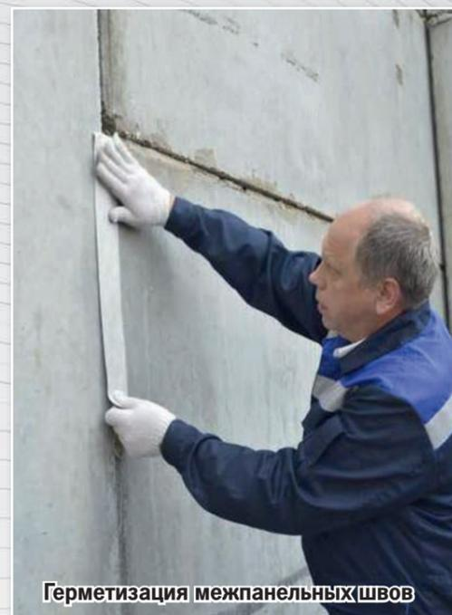
Герметизация межпанельных швов
