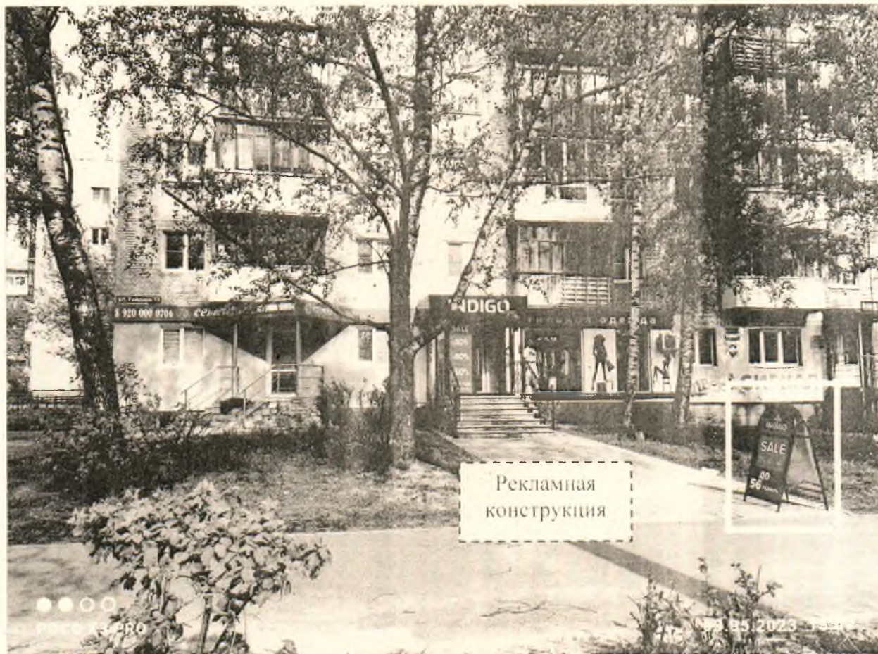
Фото № 1: Панорамный вид размещения рекламной конструкции
