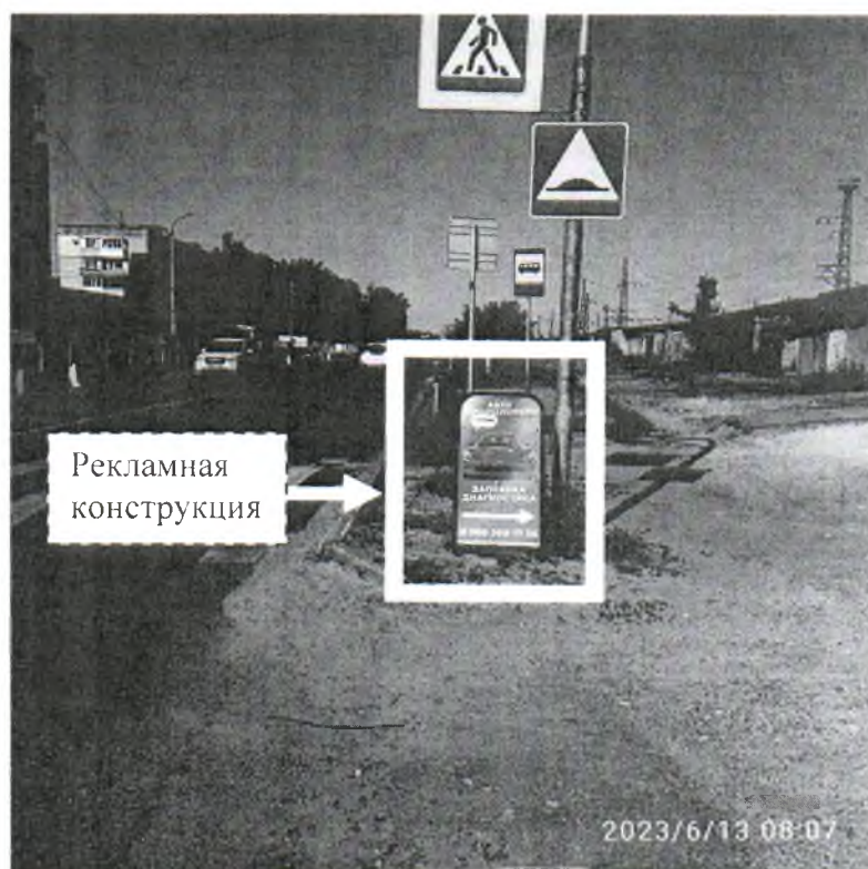
Фото №1: ул. Попова, в районе д. 15 – до проведения работ по демонтажу.
