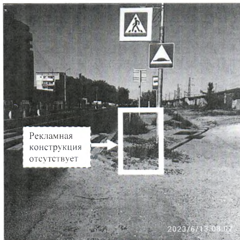
Фото №2: ул. Попова, в районе д. 15 – после проведения работ по демонтажу.
