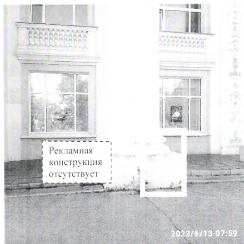
Фото №2: пр. Чкалова, в районе д. 2 – после проведения работ по демонтажу.
