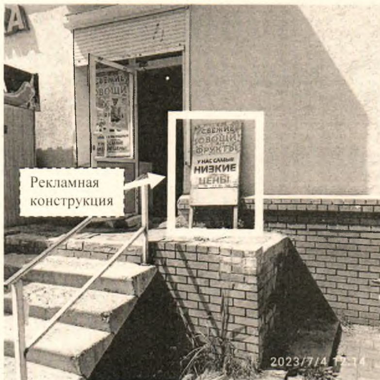
Фото №1: пр. Ленина, в районе д. 39/17 – до проведения работ по демонтажу.
