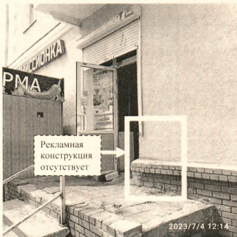
Фото №2: пр. Ленина, в районе д. 39/17 – после проведения работ по демонтажу.
