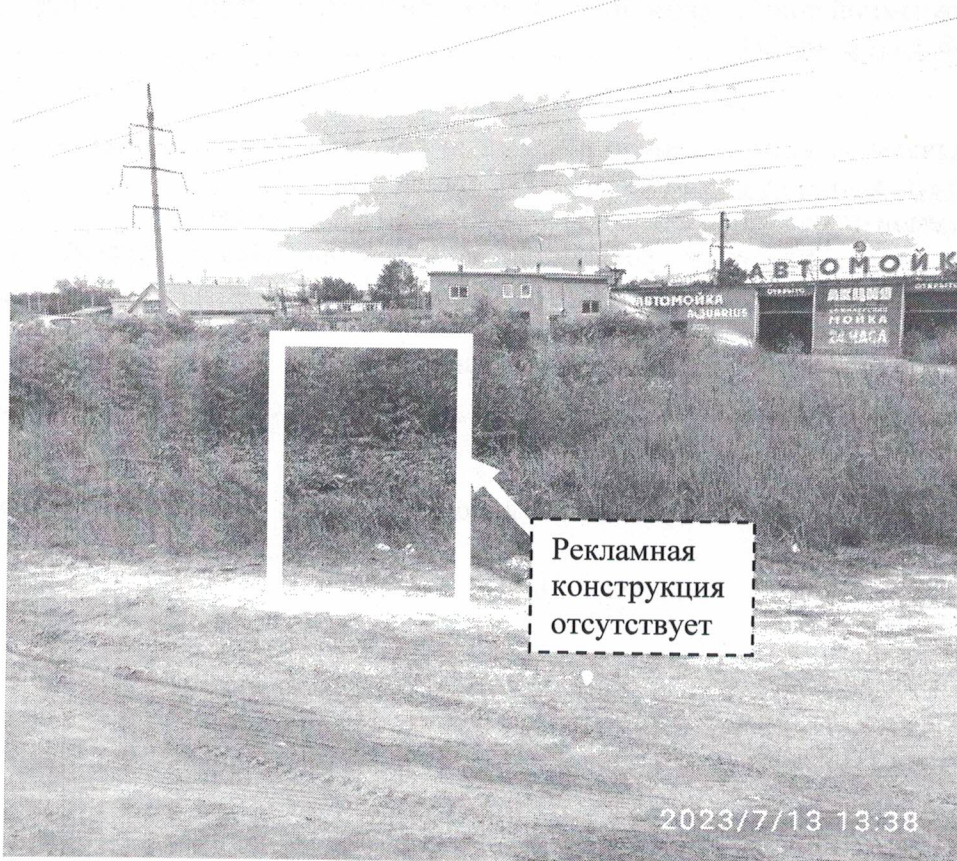
Фото №2: пр.Ленина, в районе д.1А – после проведения работ по демонтажу.
