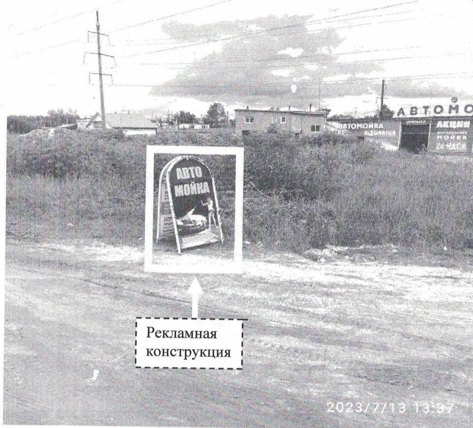
Фото №1: пр. Ленина, в районе д.1А – до проеждения работ по демонтажу.
