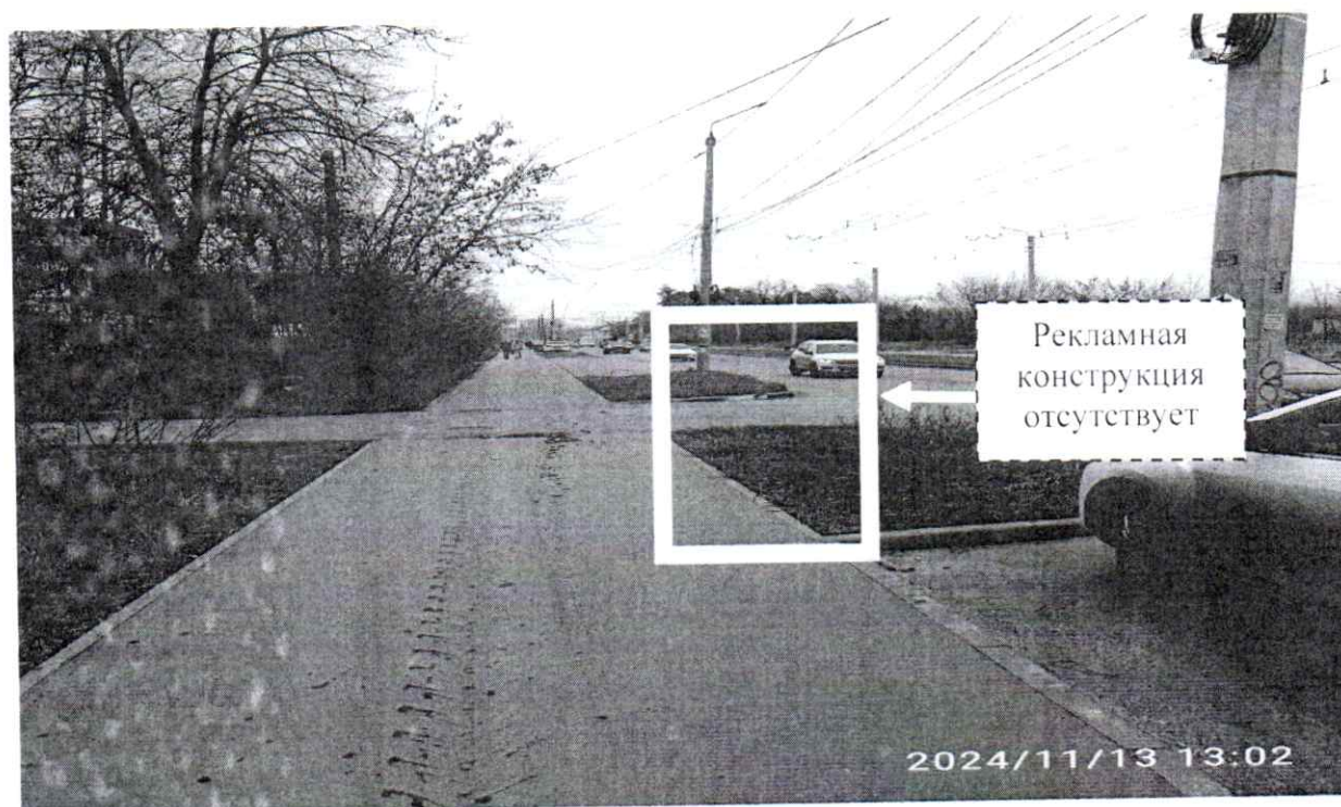
Фото № 2: ул. Терешковой, д. 20 – после проведения работ по демонтажу.
