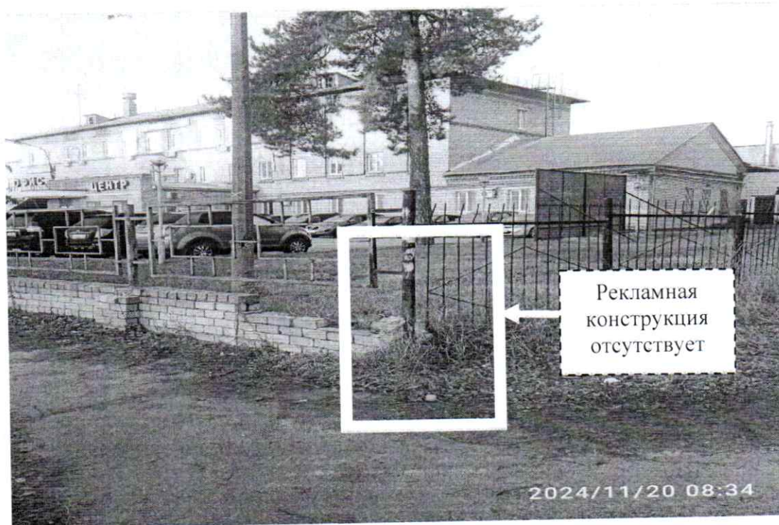
Фото № 2: ул. Ватутина, 82 – после проведения работ по демонтажу.
