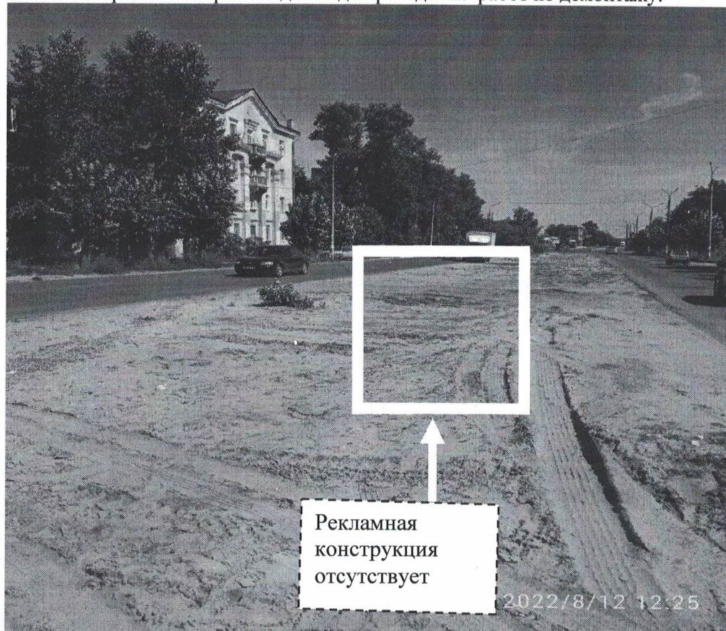
Фото №2: пр.Ленина в районе д.99 – после проведения работ по демонтажу.
