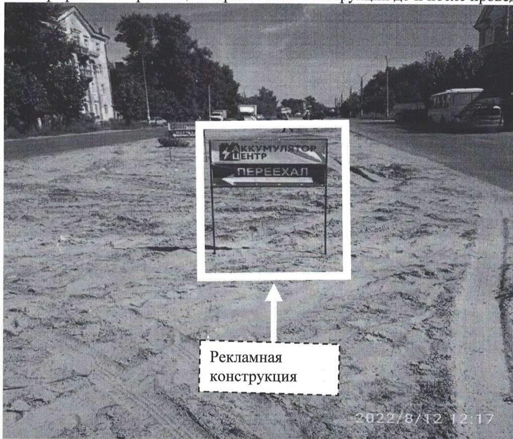
Фото №1: пр.Ленина в районе д.99 – до проведения работ по демонтажу.
