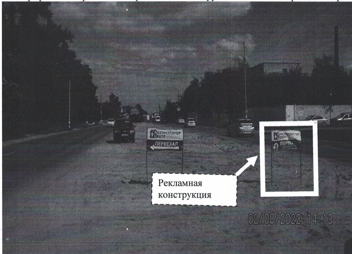
Фото №1: пр.Ленина в районе д.99 – до проведения работ по демонтажу.
