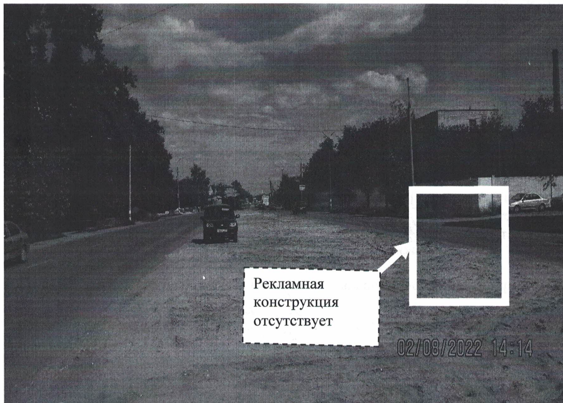
Фото №2: пр.Ленина в районе д.99 – после проведения работ по демонтажу.
