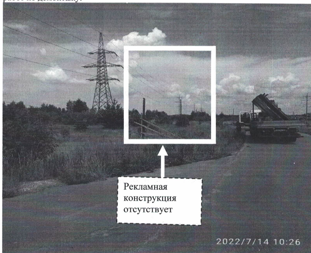
Фото №2: Автозаводское шоссе территория Восточный промрайон в районе уч.91 – после проведения работ по демонтажу.
