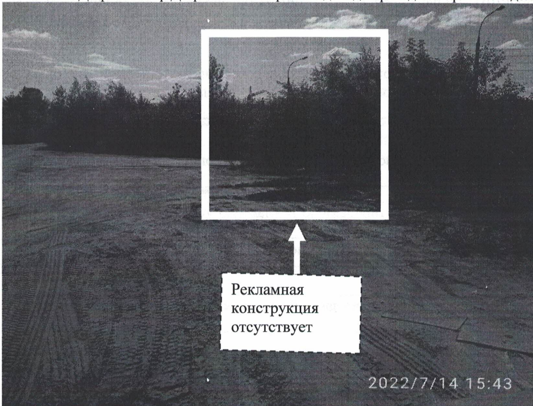
Фото №2: г.Дзержинск пр.Дзержинского в районе д.40 – после проведения работ по демонтажу.
