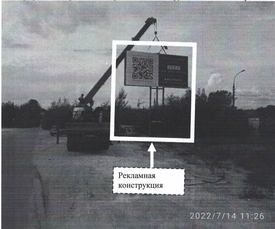
Фото №1: г.Дзержинск пр.Дзержинского в районе д.40 до проведения работ по демонтажу.
