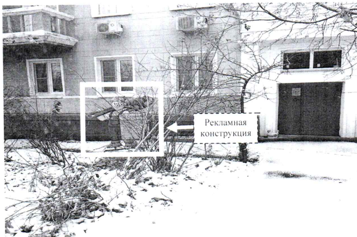
Фото № 1: пр. Ленина, д. 71 – до проведения работ по демонтажу.
