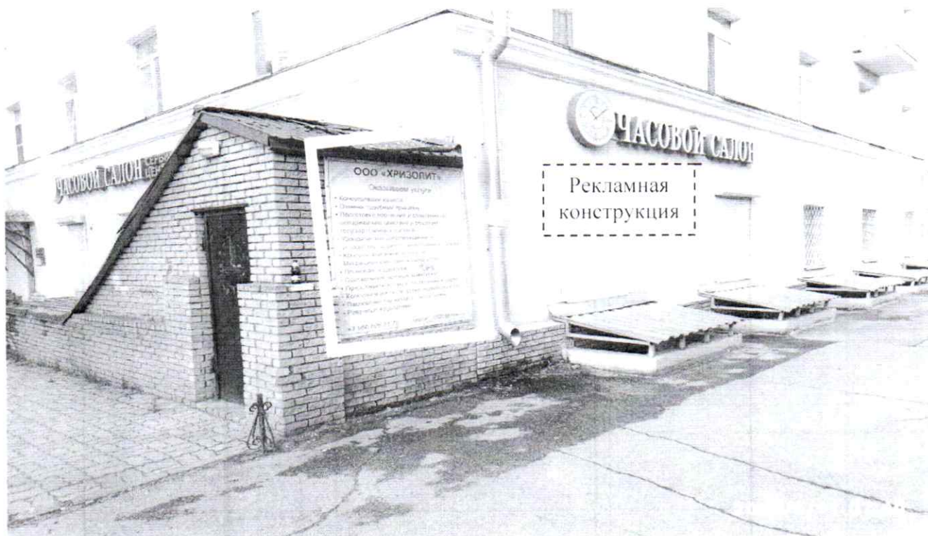
Фото № 1: пр. Дзержинского, д. 2 – до проведения работ по демонтажу.
