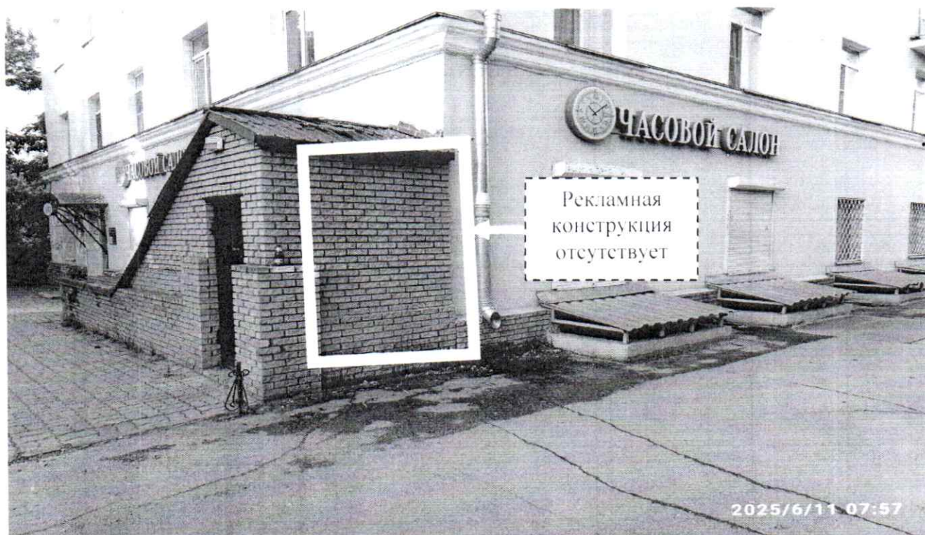
Фото № 2: пр. Дзержинского, д. 2 – после проведения работ по демонтажу.
