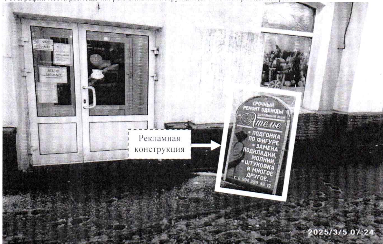
Фото № 1: пр. Ленина, д. 41 – до проведения работ по демонтажу.
