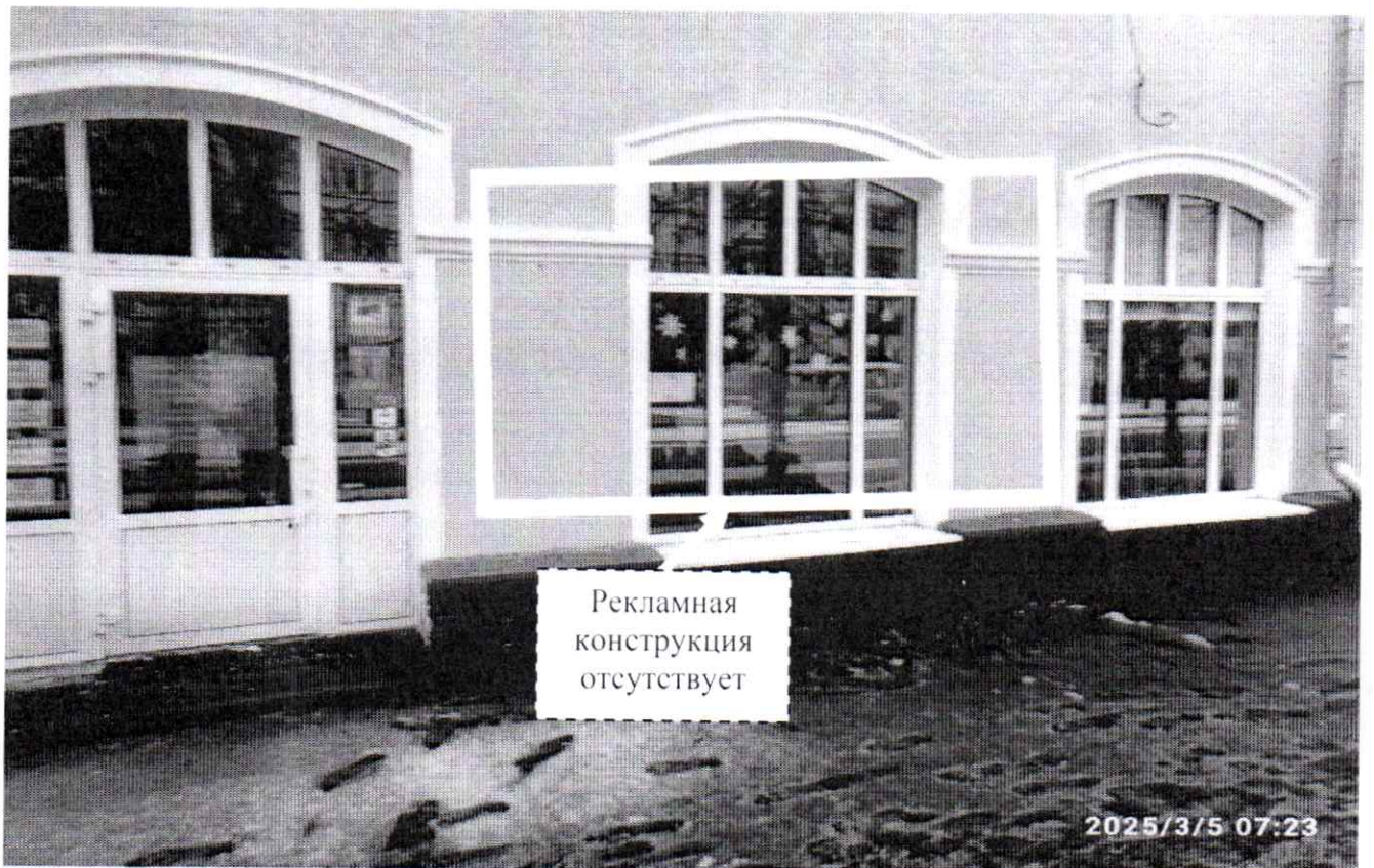
Фото № 2: пр. Ленина, д. 43 – после проведения работ по демонтажу.
