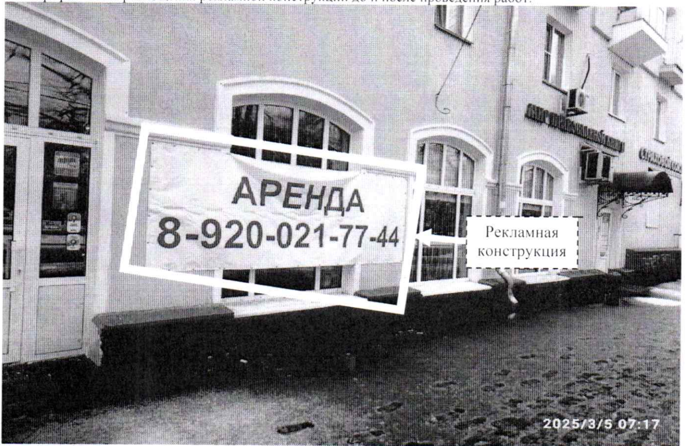
Фото № 1: пр. Ленина, д. 43 – до проведения работ по демонтажу.
