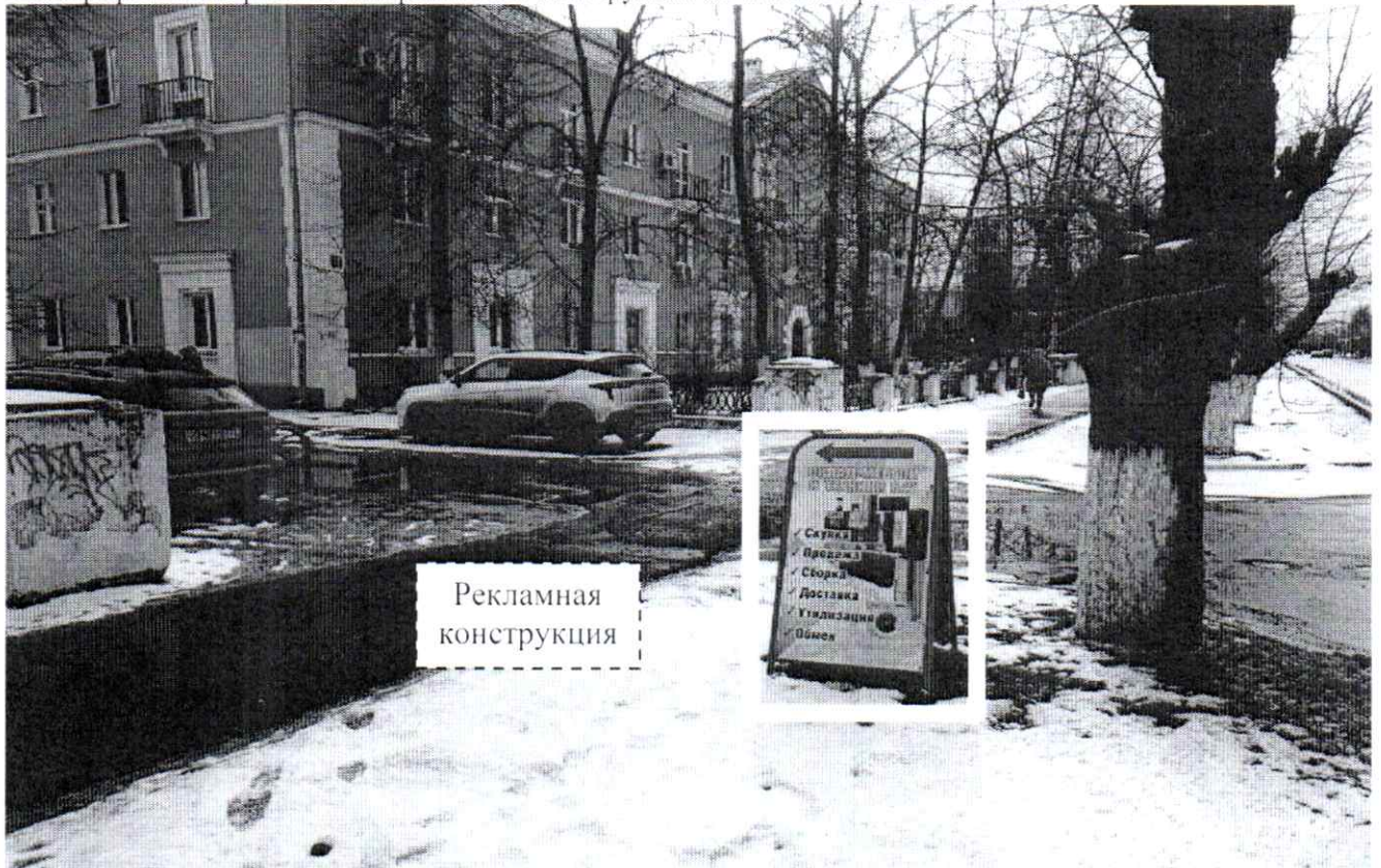
Фото № 1: пр. Чкалова, д. 20 – до проведения работ по демонтажу.
