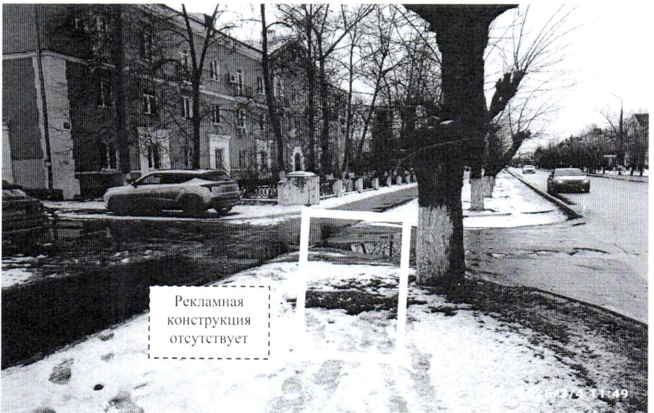
Фото № 2: пр. Чкалова, д. 20 – после проведения работ по демонтажу.
