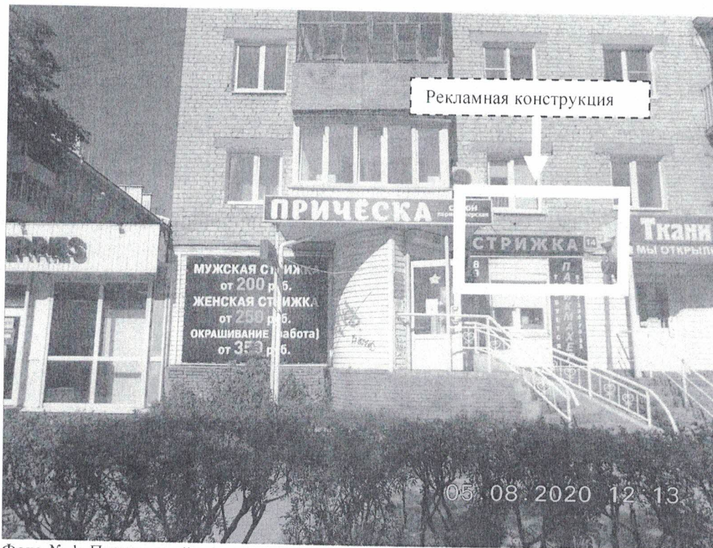
Фото № 1: Панорамный вид размещения рекламной конструкции
