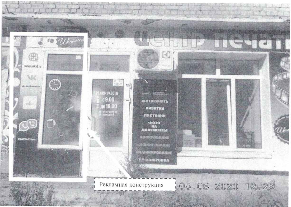
Фото № 1: Панорамный вид размещения рекламной конструкции
