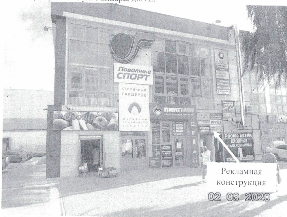
Фото № 1: Панорамный вид размещения рекламной конструкции.
