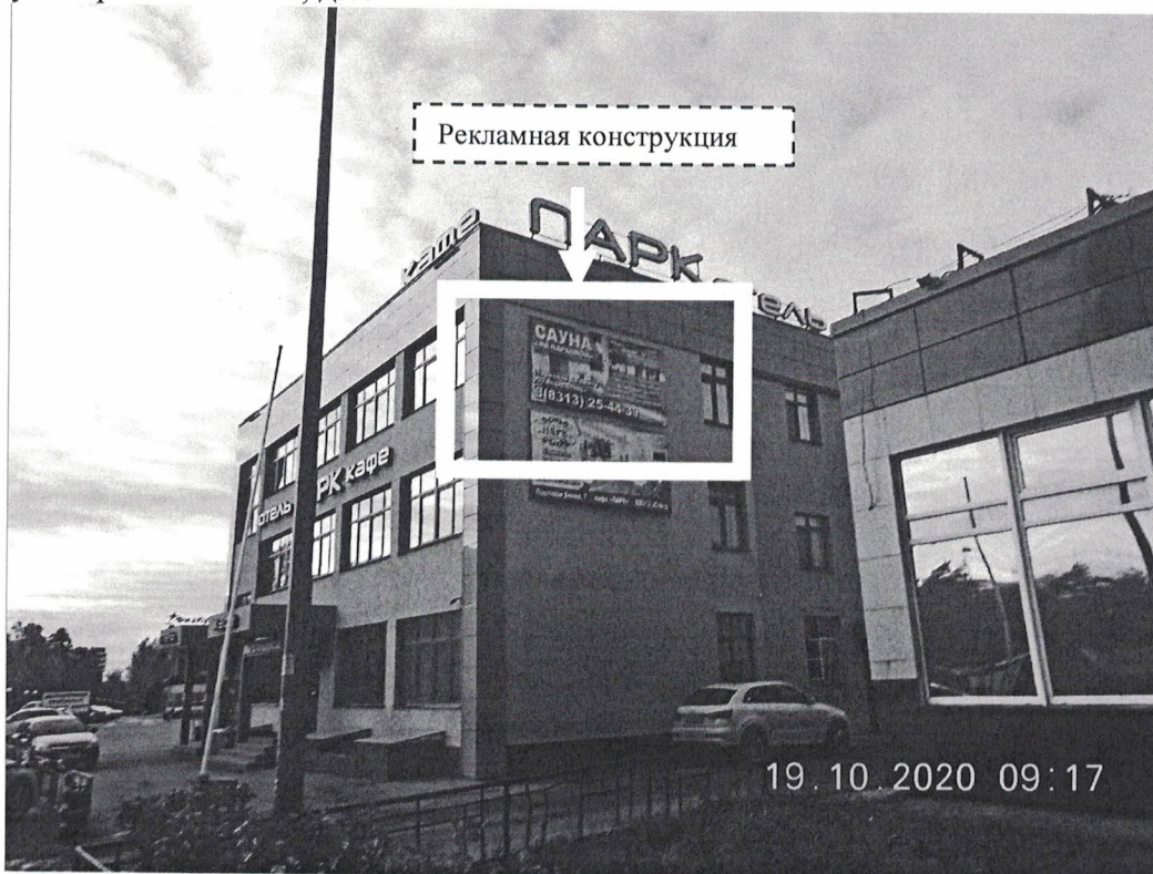
Фото № 1: Панорамный вид размещения рекламной конструкции
