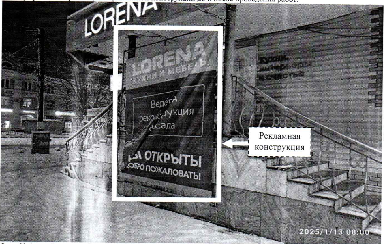
Фото № 1: пр. Ленина, д. 34 – до проведения работ по демонтажу.
