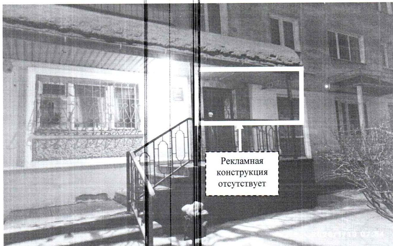
Фото № 2: ул. Грибоедова, д. 27 – после проведения работ по демонтажу.
