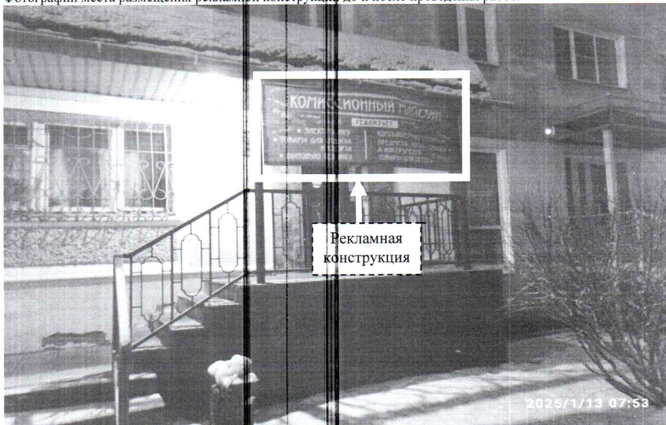
Фото № 1: ул. Грибоедова, д. 27 – до проведения работ по демонтажу.
