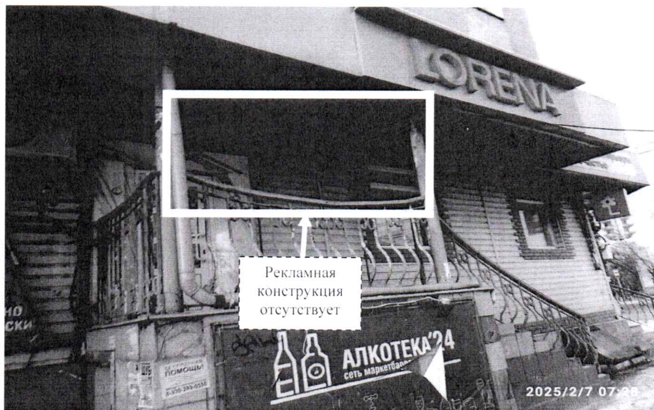
Фото № 2: пр. Ленина, д. 34 – после проведения работ по демонтажу.
