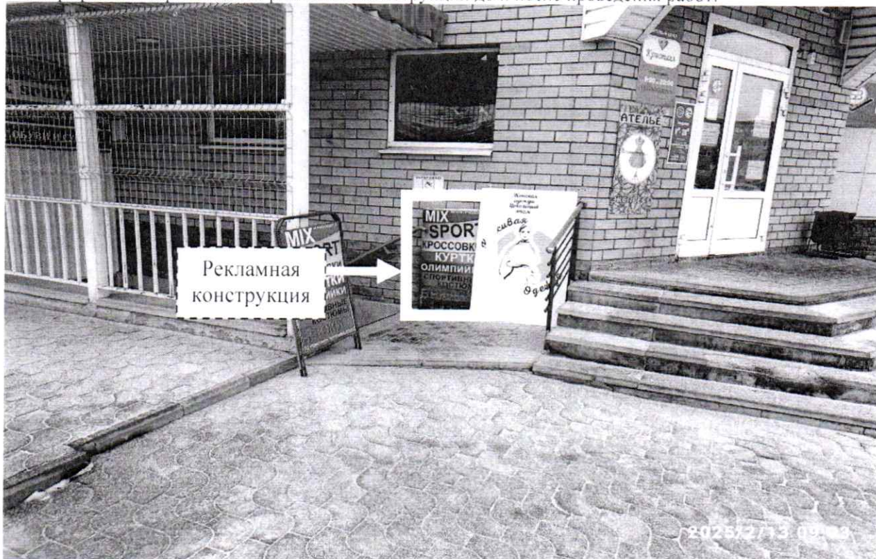
Фото № 1: ул. Гайдара, д. 59г – до проведения работ по демонтажу.
