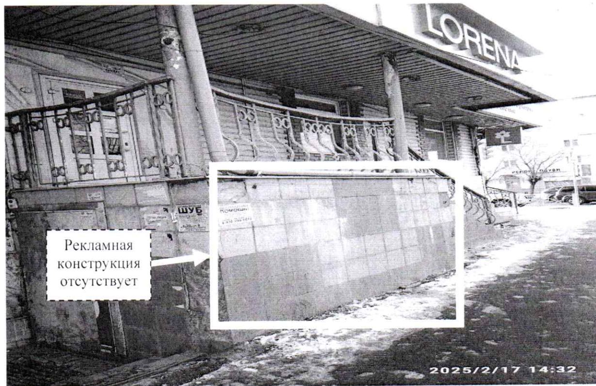
Фото № 2: пр. Ленина, д. 34/20 – после проведения работ по демонтажу.
