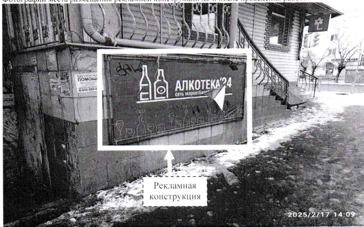
Фото № 1: пр. Ленина, д. 34/20 – до проведения работ по демонтажу.
